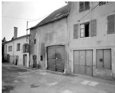
Façade sur l'impasse. Phot. Jérôme Mongreville IVR43_19872500816V
