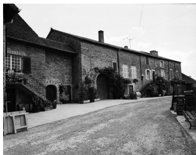
Fermes situées rue du Serin : vue d'ensemble. Phot. Yves Sancey IVR43_19813900262X
