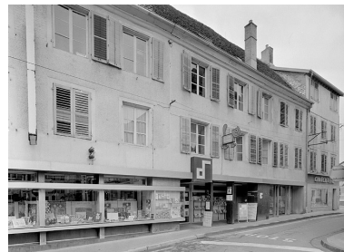
Façade sur la place. Phot. Jérôme Mongreville IVR43_19872501262V
