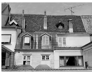
Façade sur cour vue à partir du premier étage. A gauche, le corps d'escalier dont la première travée à gauche a été surélevée. Phot. Jérôme Mongreville IVR43_19872500826X
