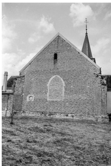
Façade postérieure. Phot. Guy Forestier IVR43_19753900138Z
