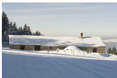
Façade antérieure, en hiver. Phot. Jérôme Mongreville IVR43_20082500951NUC2A
