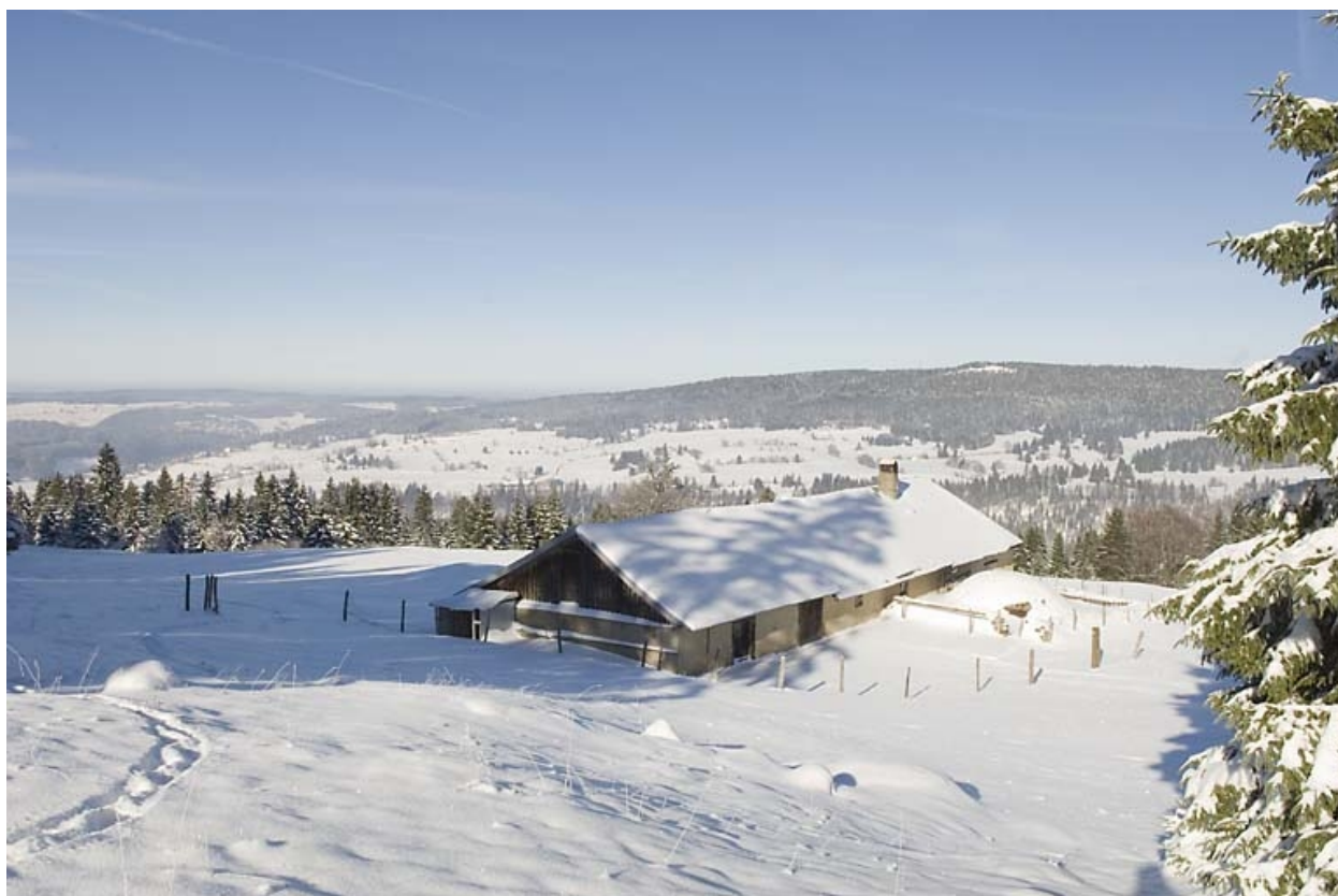
Vue d'ensemble depuis le nord, en hiver.
