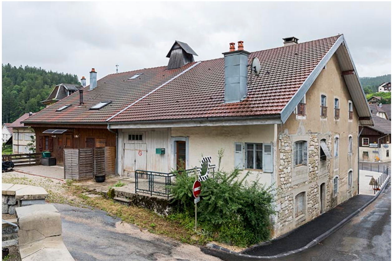
Façades postérieure et latérale gauche.
