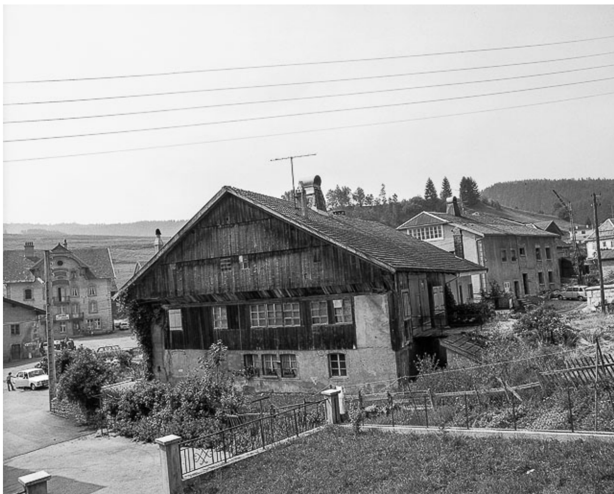
Façades postérieure et latérale droite, en 1976.
