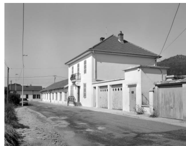
Atelier de fabrication, bureau et logement. Phot. Yves Sancey IVR43_19973901436X
