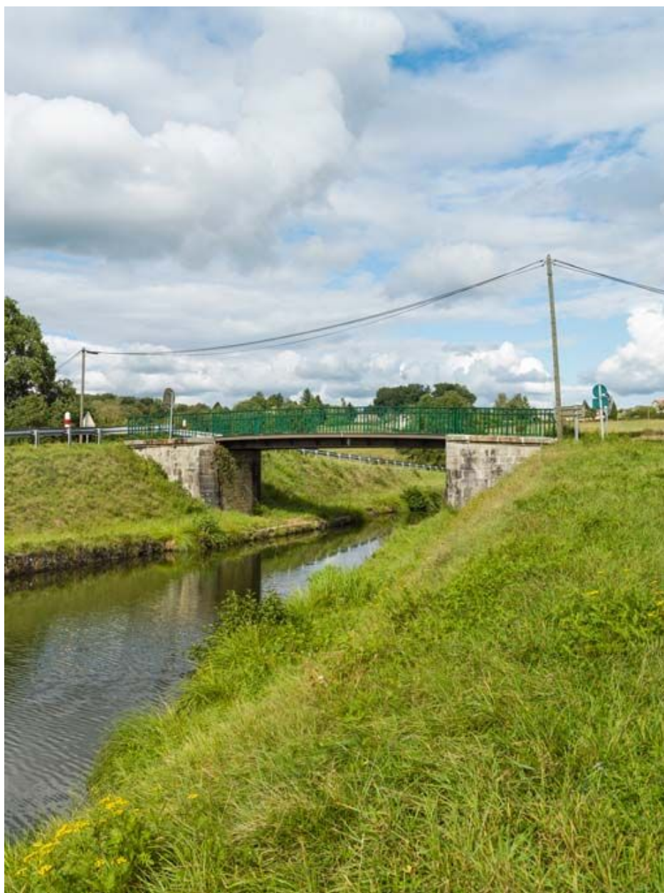
Vue d'ensemble du pont.
