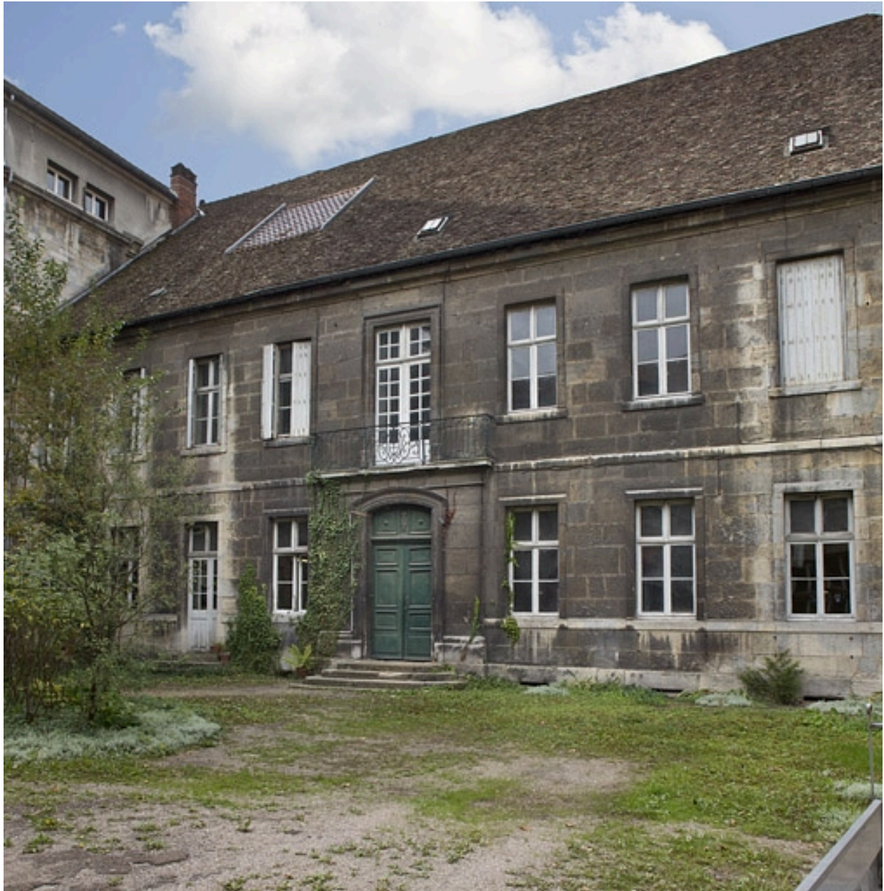
Logis principal : vue d'ensemble de la façade sur cour, de trois quarts droit.
