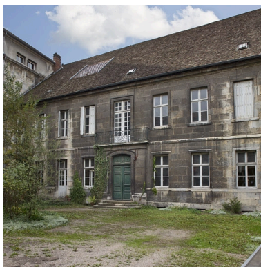
Logis principal : vue d'ensemble de la façade sur cour, de trois quarts droit.
