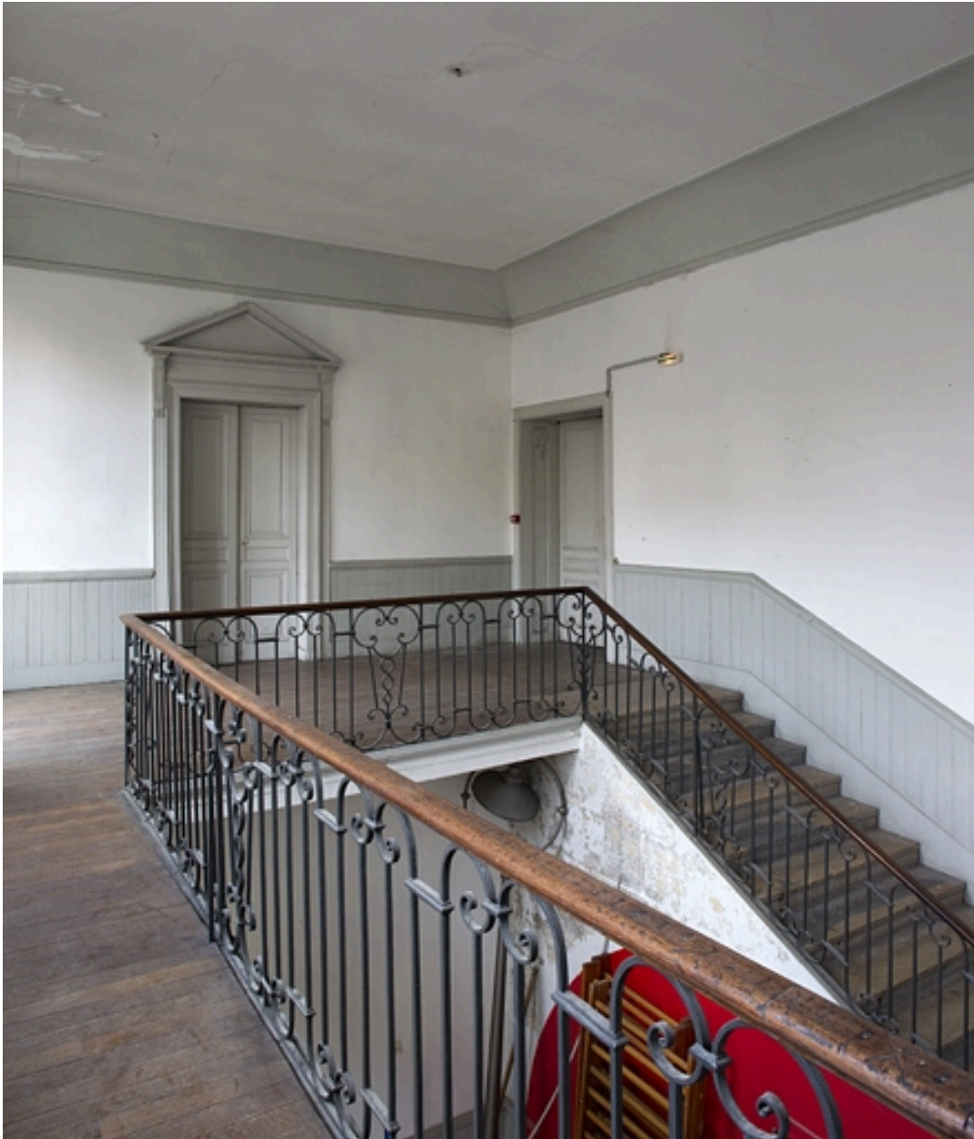
Logis principal, intérieur : vue d'ensemble de l'escalier.
