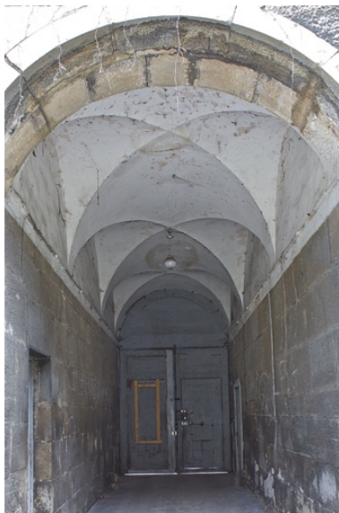
Logis secondaire : détail du passage cocher voûté d'arêtes.
