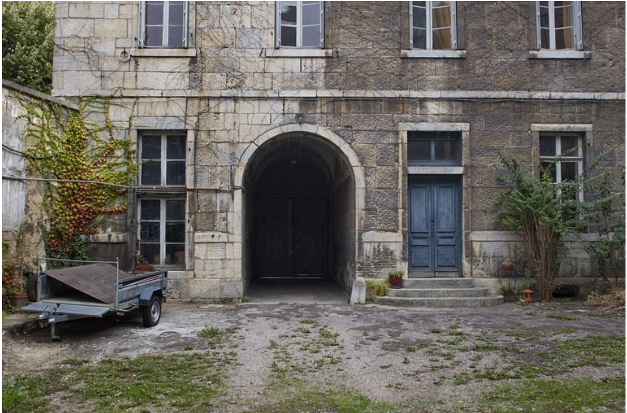
Logis secondaire : détail de façade sur cour, partie gauche, de face.
