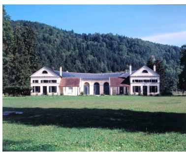
Vue d'ensemble de la ferme, de face. Phot. Yves Sancey IVR43_19923901072XA
