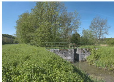
Vanne de prise d'eau. Phot. Thierry Kuntz IVR26_20122102481NUC4A
