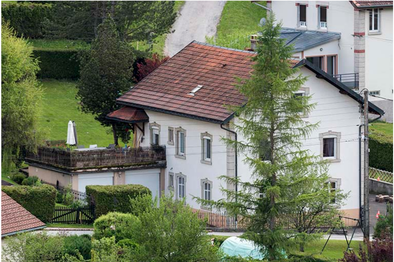
Façades postérieure et latérale gauche (vue plongeante).
