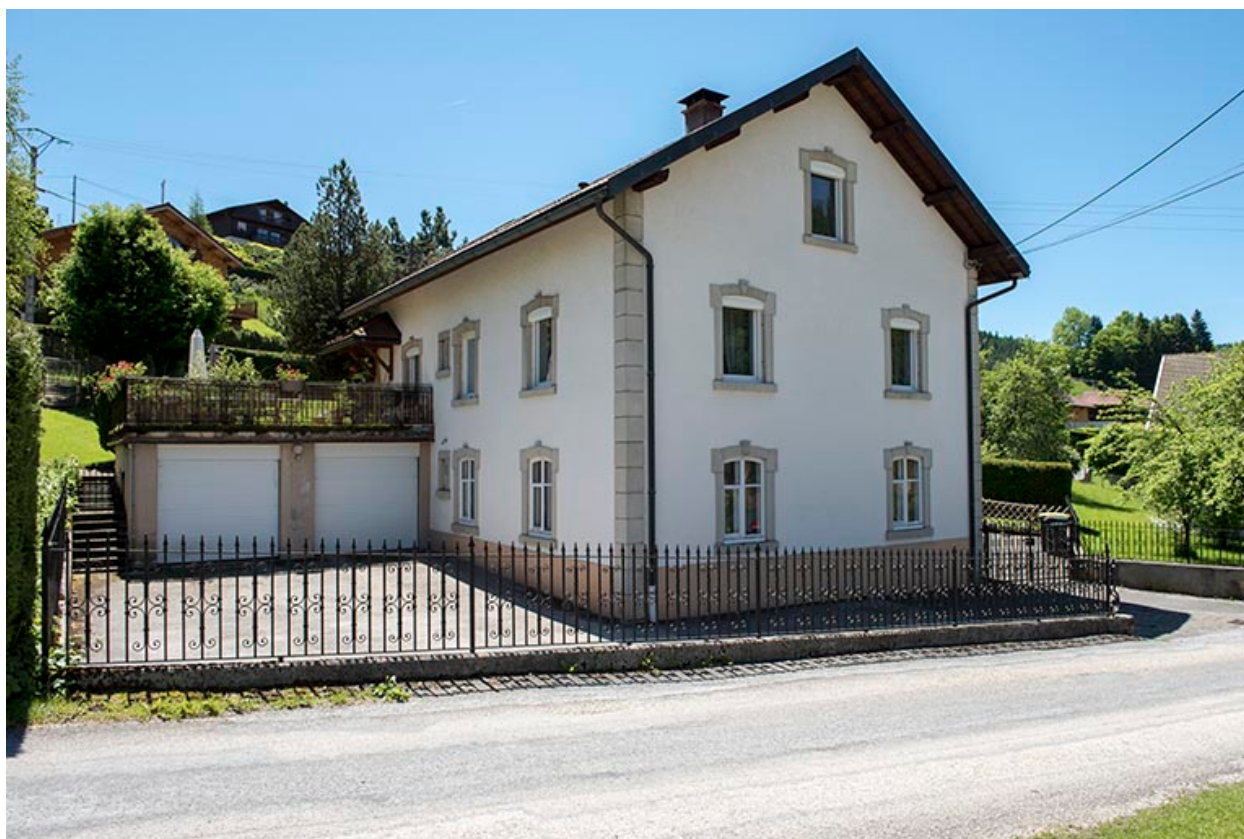
Façades postérieure et latérale gauche.
