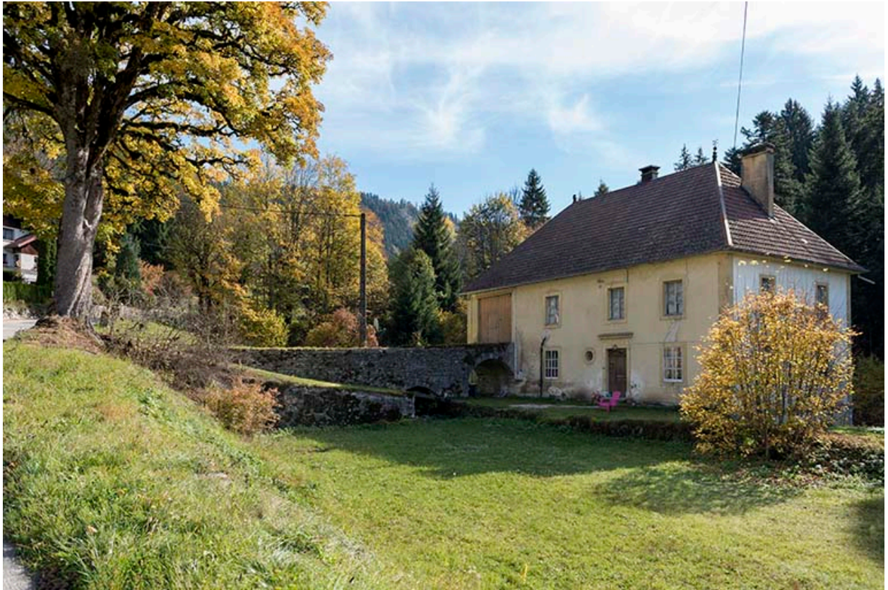
Vue d'ensemble rapprochée, depuis le nord-ouest.
