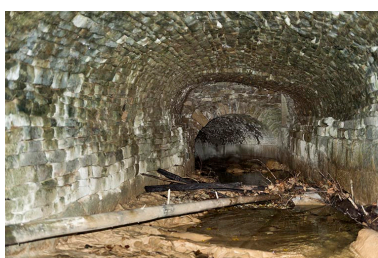
Voûte sur le ruisseau couvert. Phot. Sonia Dourlot IVR43_20172501714NUC4A
