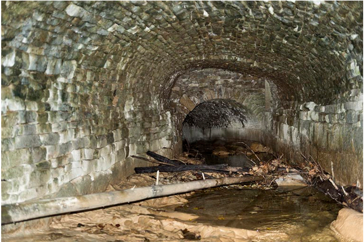
Voûte sur le ruisseau couvert.
