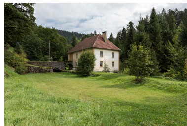
Vue d'ensemble depuis le nord- ouest, avec l'ancien bassin de retenue au premier plan. Phot. Sonia Dourlot IVR43_20172501711NUC4A
