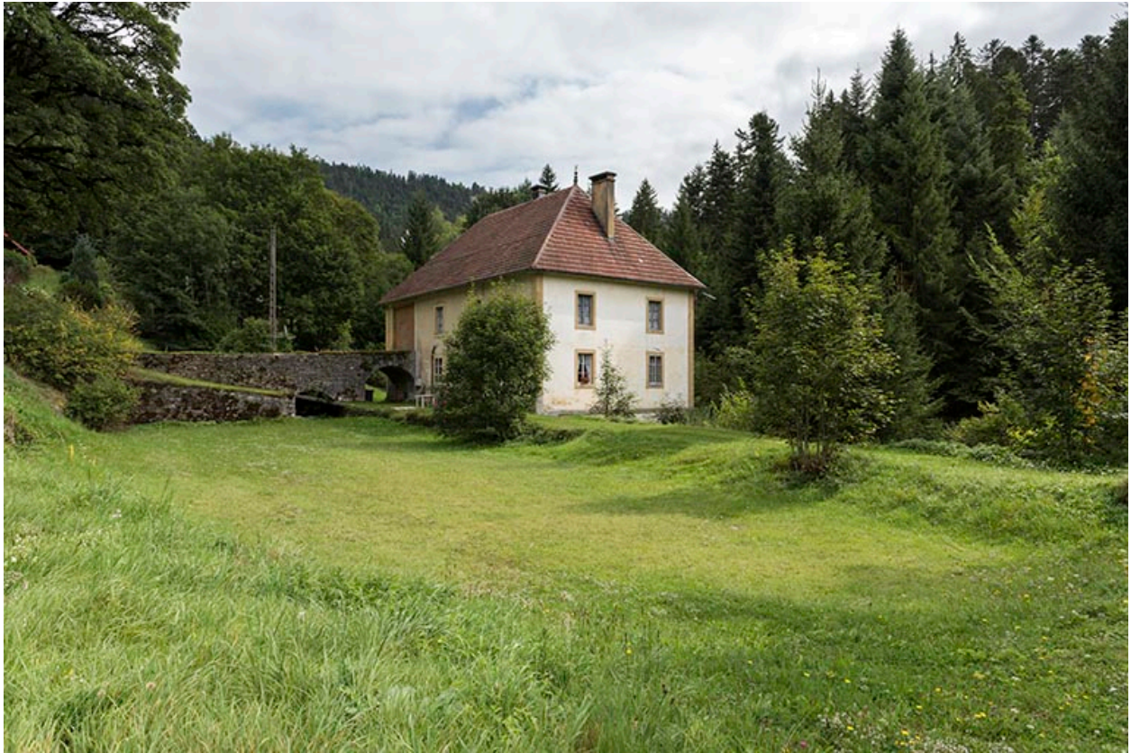
Vue d'ensemble depuis le nord-ouest, avec l'ancien bassin de retenue au premier plan.
