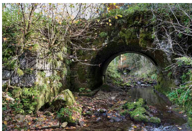
Pont en aval, à l'ouest. Phot. Sonia Dourlot IVR43_20172501716NUC4A
