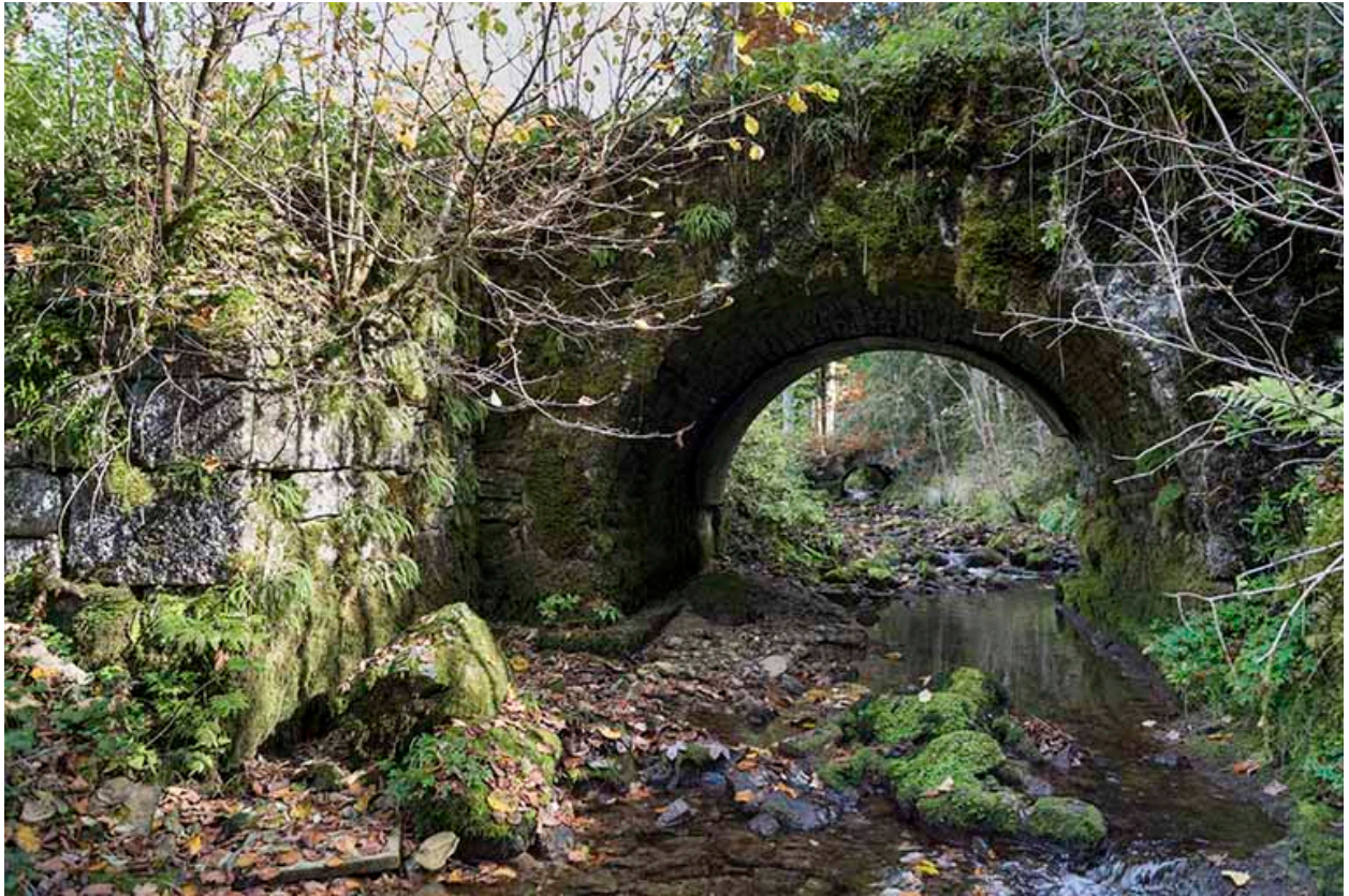
Pont en aval, à l'ouest.
