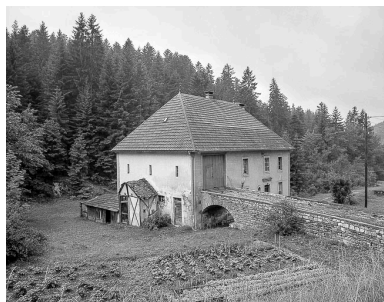
Vue d'ensemble, en 1976. Phot. Dominique Humbert IVR43_19762500400X
