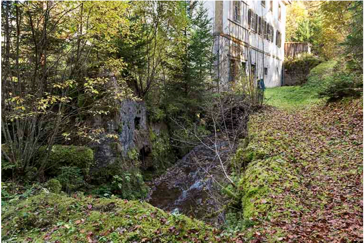
Canal de fuite et vestiges du soubassement du martinet.
