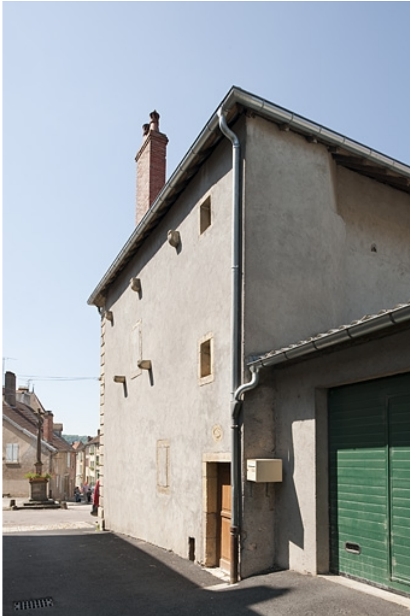
Vue générale de la façade latérale droite.
