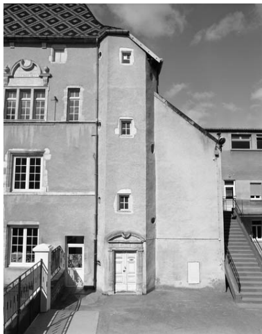
Détail de la tour d'escalier, de face. Phot. Yves Sancey IVR43_19917000146X
