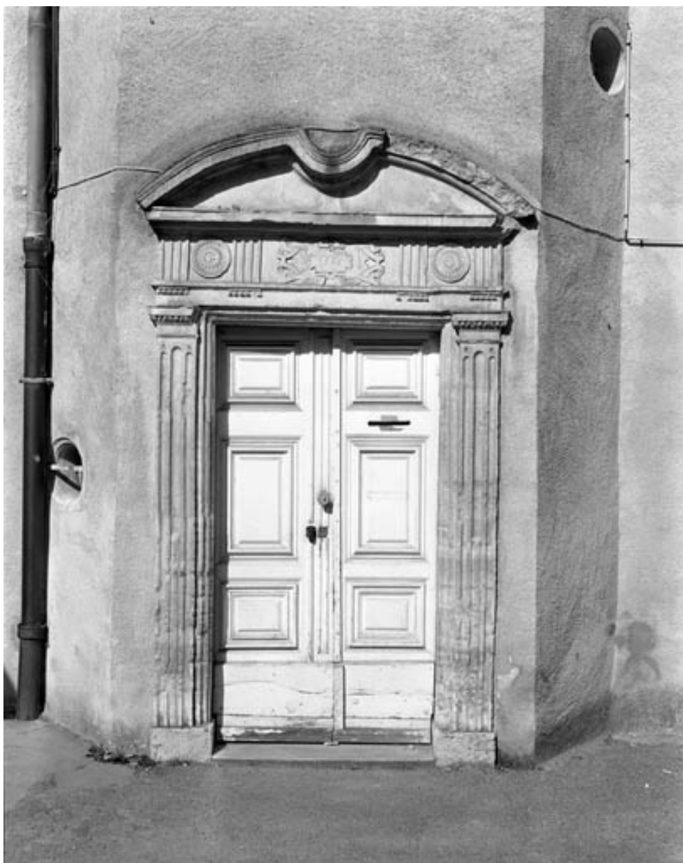
Détail de la porte d'entrée de l'escalier.
