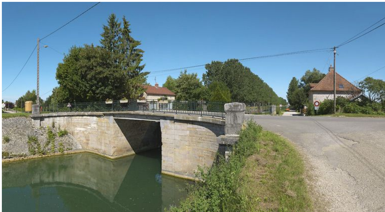
Vue d'ensemble prise d'aval.
