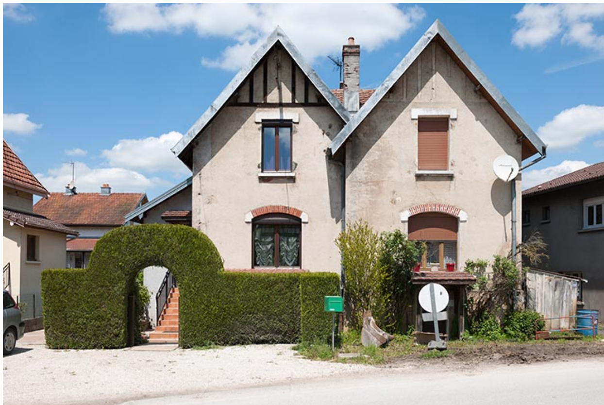
Façade antérieure d'une maison jumelée.
