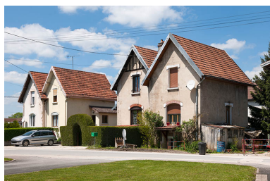
Maisons jumelées vues de trois quarts. Phot. Jérôme Mongreville IVR43_20132500462NUC4A
