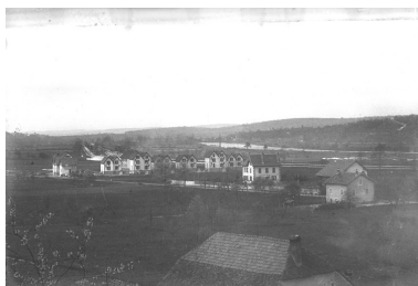
La cité ouvrière vue depuis le nord-est. Phot. , Autr. Mayer (photographe) IVR43_20122501530NUC2
