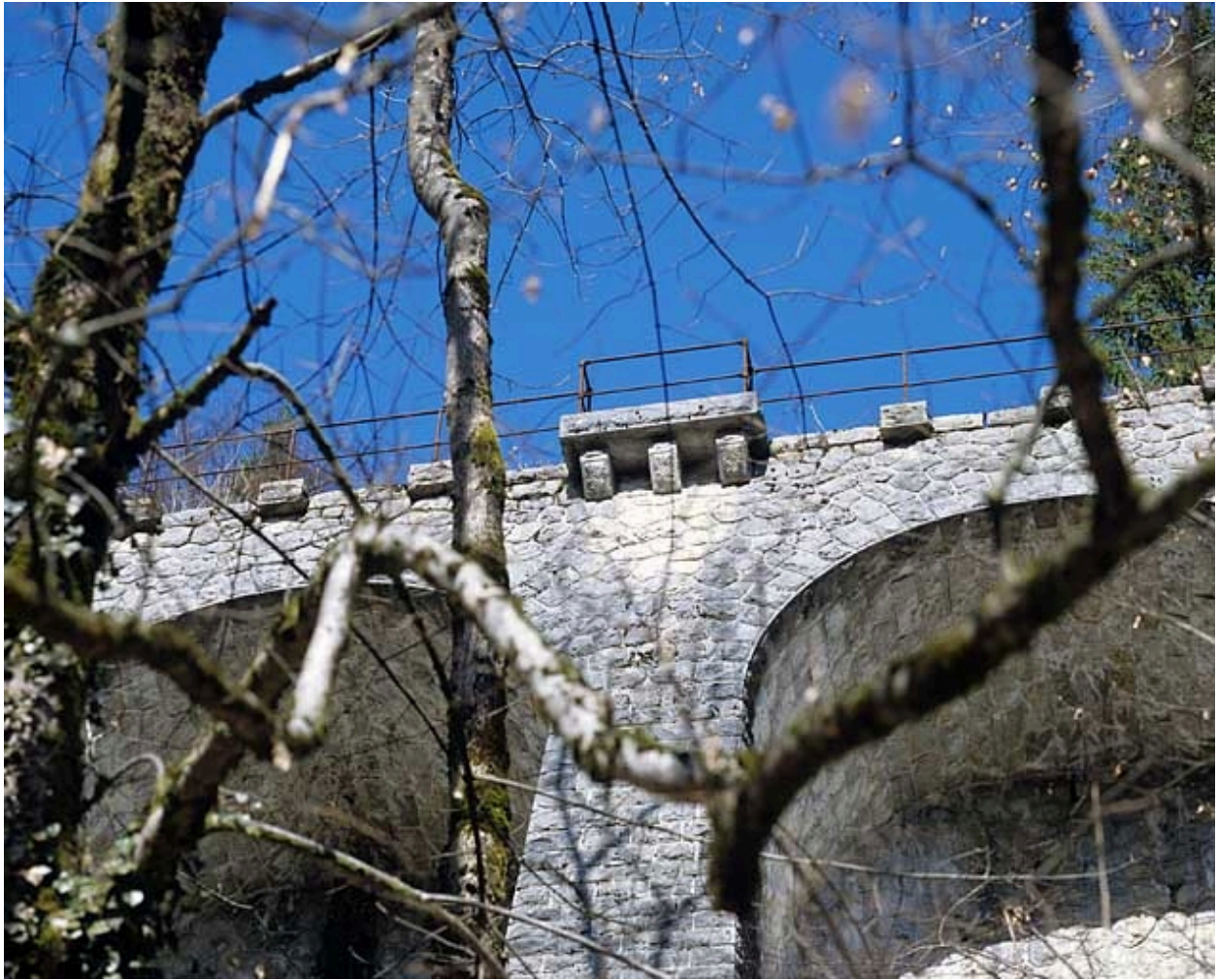
Pile centrale et refuge, vus en contre-plongée.
