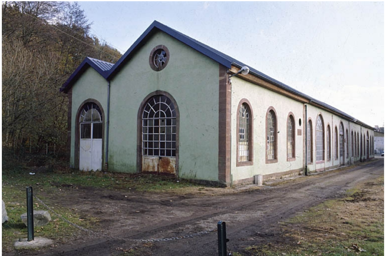
Salle des machines depuis le nord.
