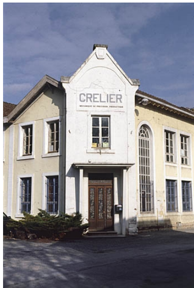
Bâtiment d'entrée : bureaux. Phot. Jérôme Mongreville IVR43_20019000591ZA
