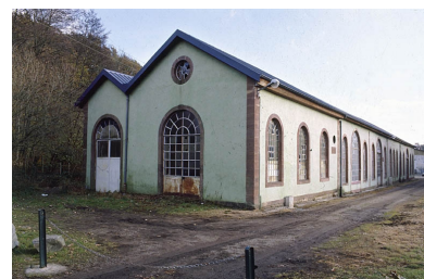
Salle des machines depuis le nord. Phot. Jérôme Mongreville IVR43_20019000551ZA
