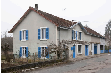
Façade antérieure et façade latérale gauche. Phot. Jérôme Mongreville IVR43_20112502922NUC4A
