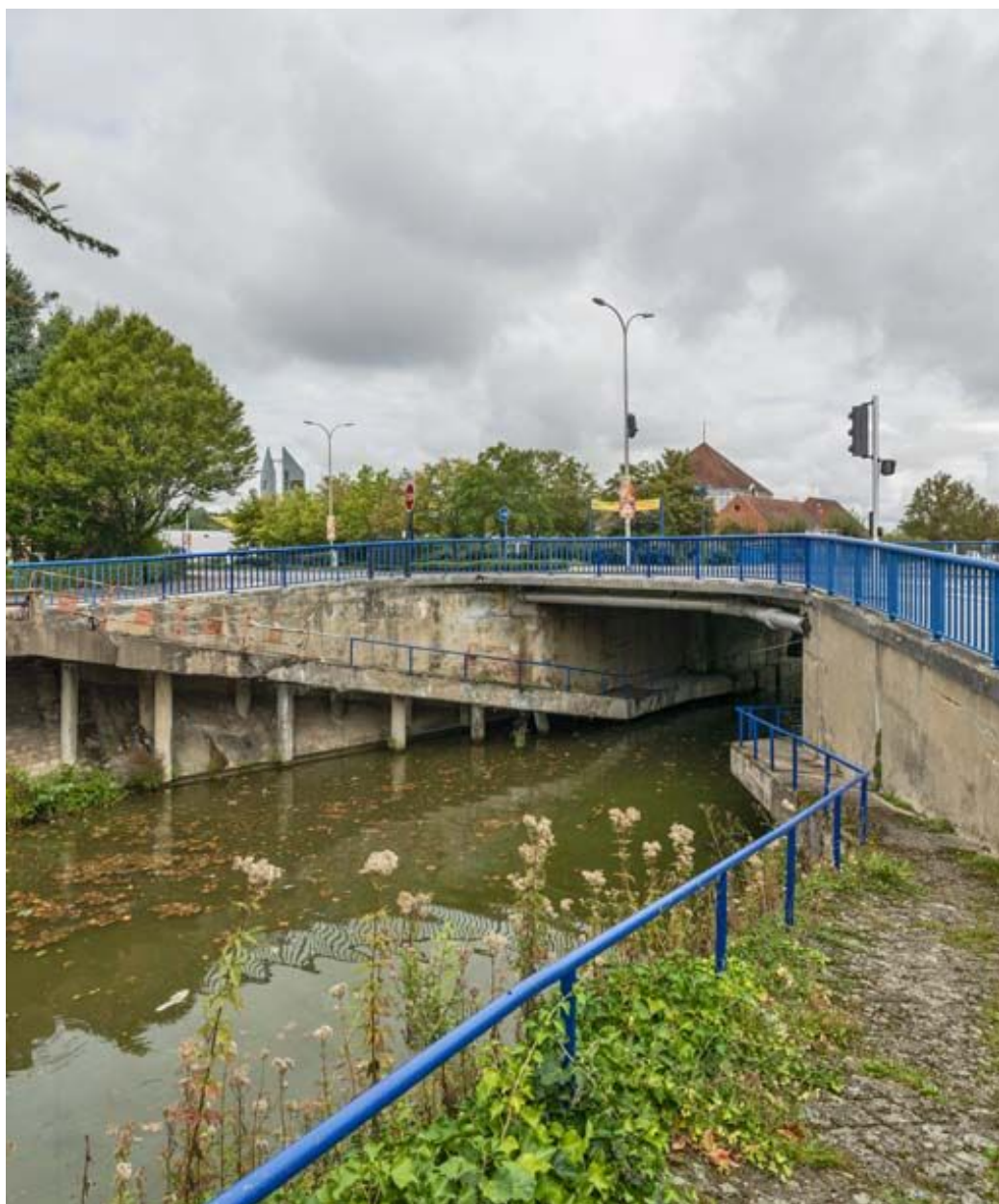
Vue d'ensemble du pont.
