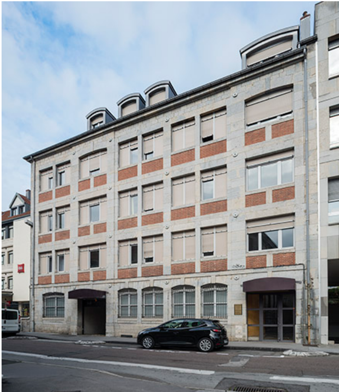
Usine d'horlogerie (23 rue Gambetta, Besançon).
