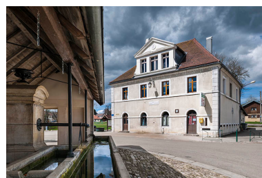
Mairie-fromagerie de Saint-Antoine. Phot. Jérôme Mongreville IVR43_20162500294NUC4A
