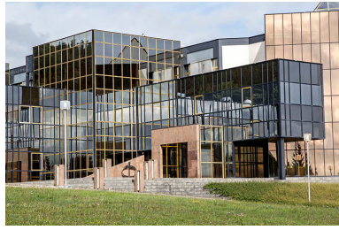
Usine de bijouterie et joaillerie Christian Bernard à Maîche. Phot. Yves Sancey IVR43_20132502953NUC2A
