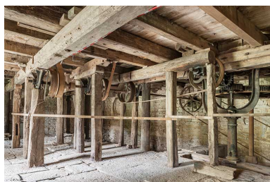
Moulin de Fourbanne. Beffroi à l'étage de soubassement. Phot. Jérôme Mongreville IVR43_20142501173NUC4A
