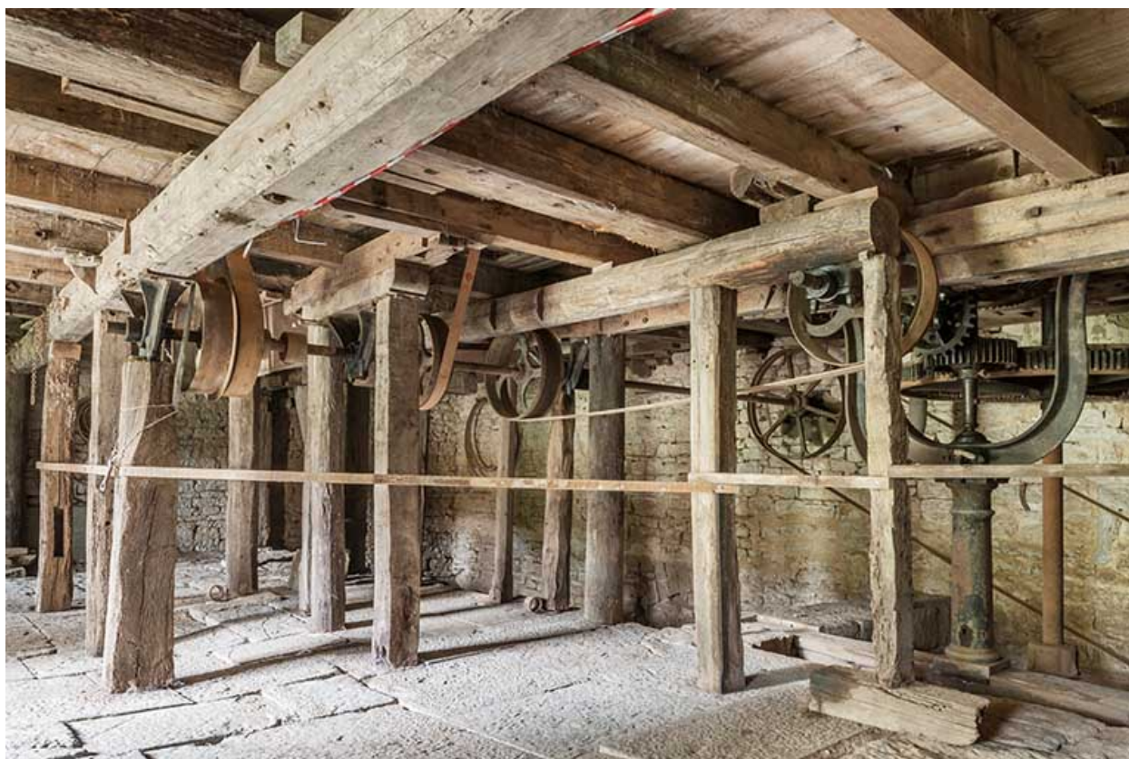
Moulin de Fourbanne. Beffroi à l'étage de soubassement.
