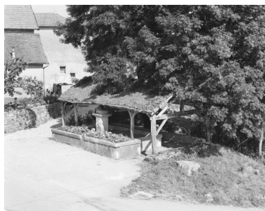
Vue générale. Phot. Yves Sancey IVR43_19793900088X
