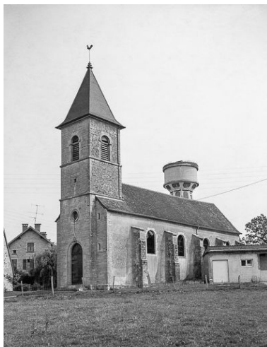
Façade antérieure et face droite. Phot. Yves Sancey IVR43_19843900287V
