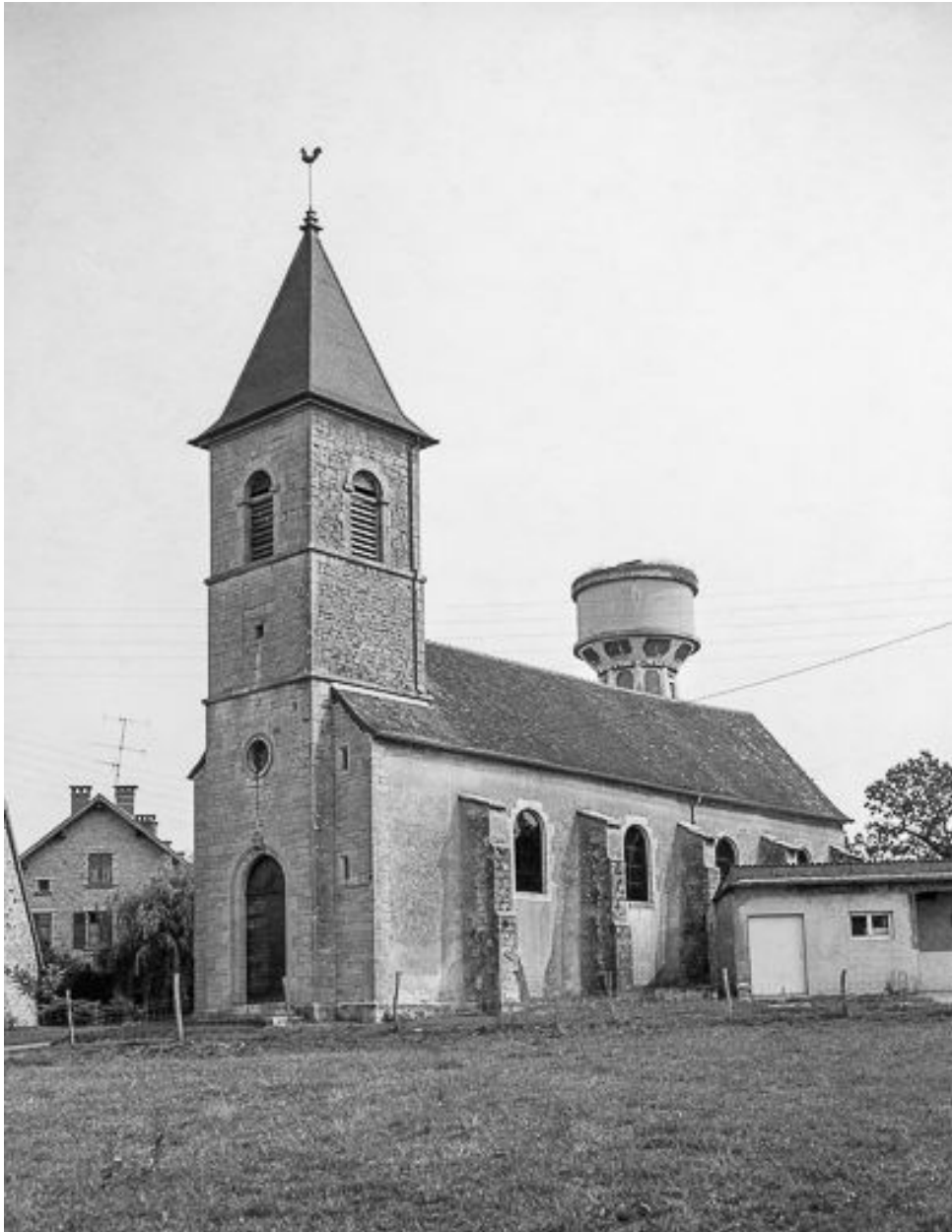
Façade antérieure et face droite.
