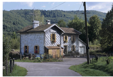
Façades antérieure et latérale gauche. Phot. Yves Sancey IVR43_20043900321ZA
