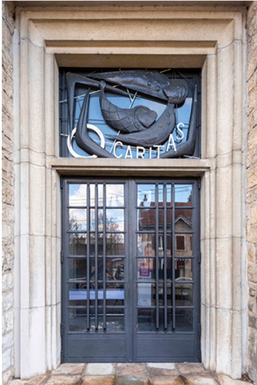
Vue de la porte et du châssis de tympan de droite.
