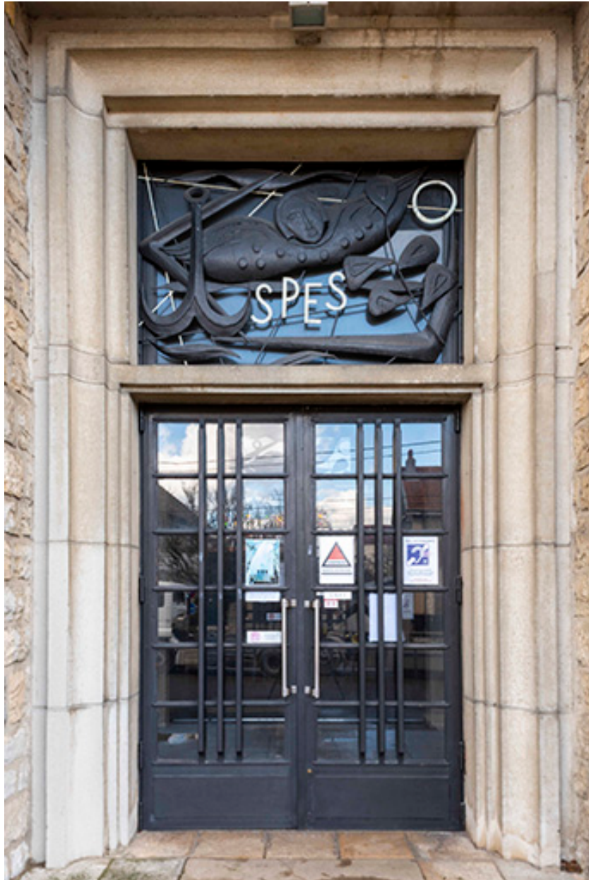
Vue de la porte centrale et de son châssis de tympan.
