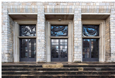
Vue d'ensemble des trois portes et châssis de tympan. Phot. Aline Thomas IVR43_20222500073NUC4A
