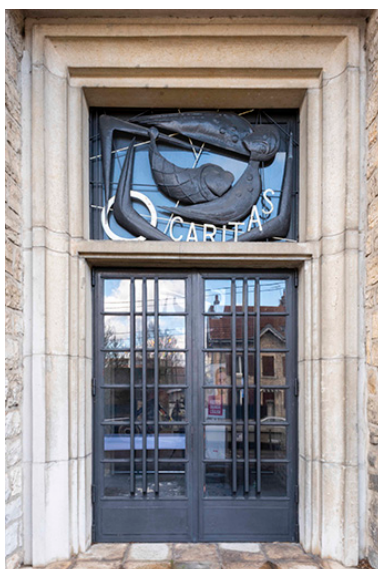
Vue de la porte et du châssis de tympan de droite. Phot. Aline Thomas IVR43_20222500076NUC4A
