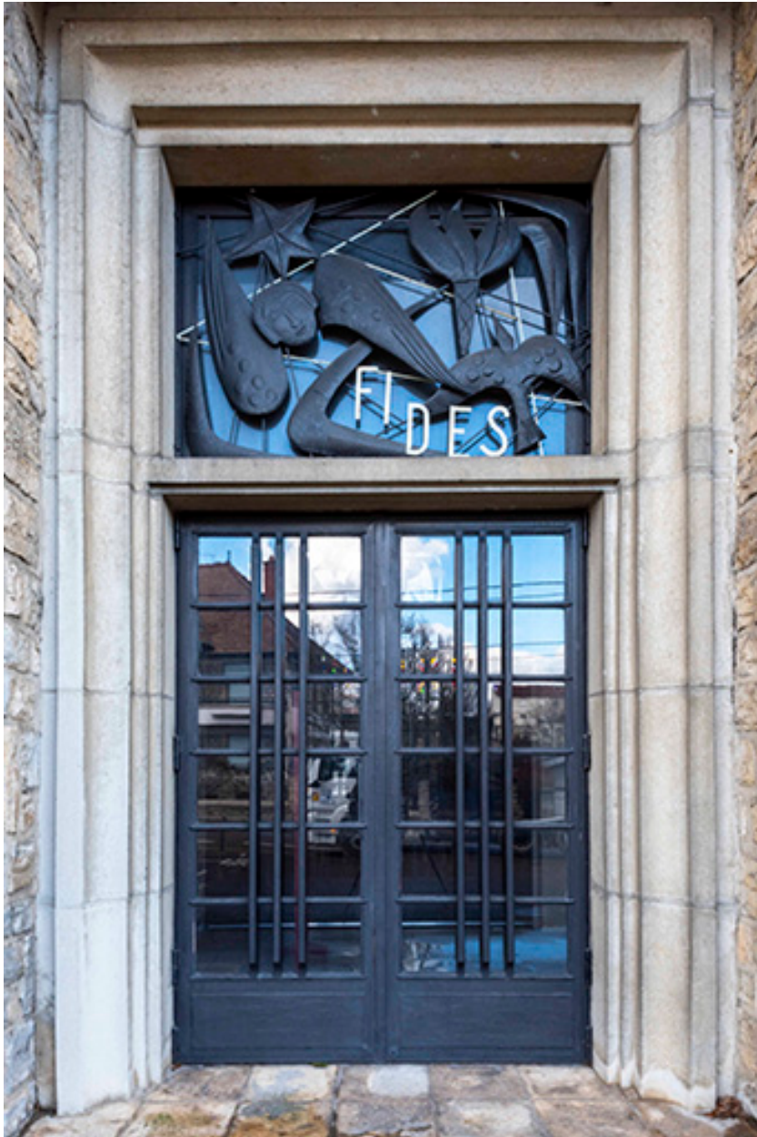
Vue de la porte et du châssis de tympan de gauche.
