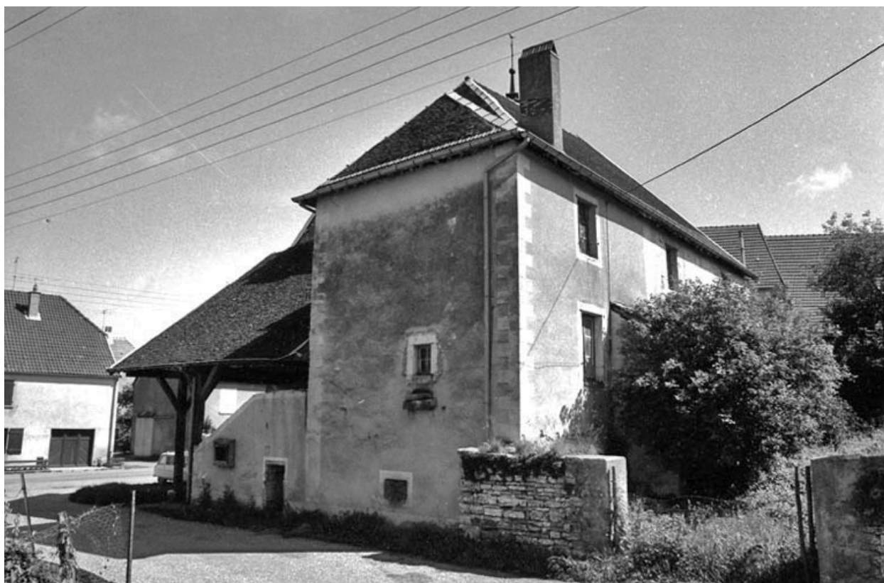
Façade postérieure en 1981.
