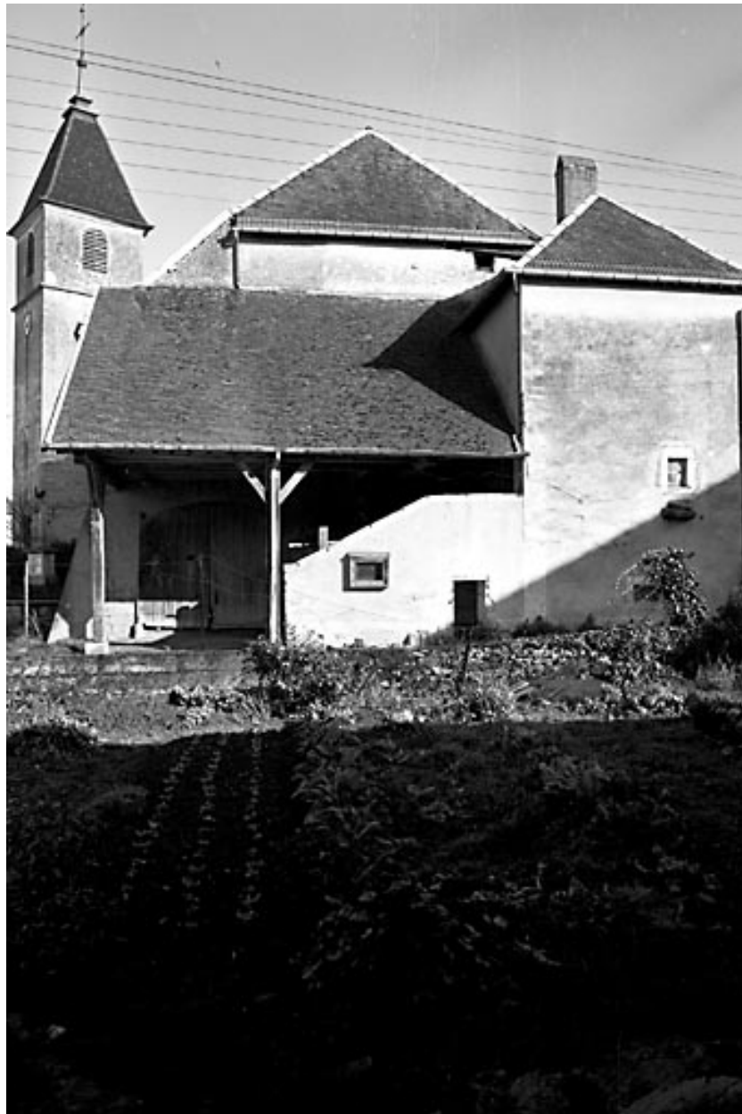
Façade latérale droite en 1984.
