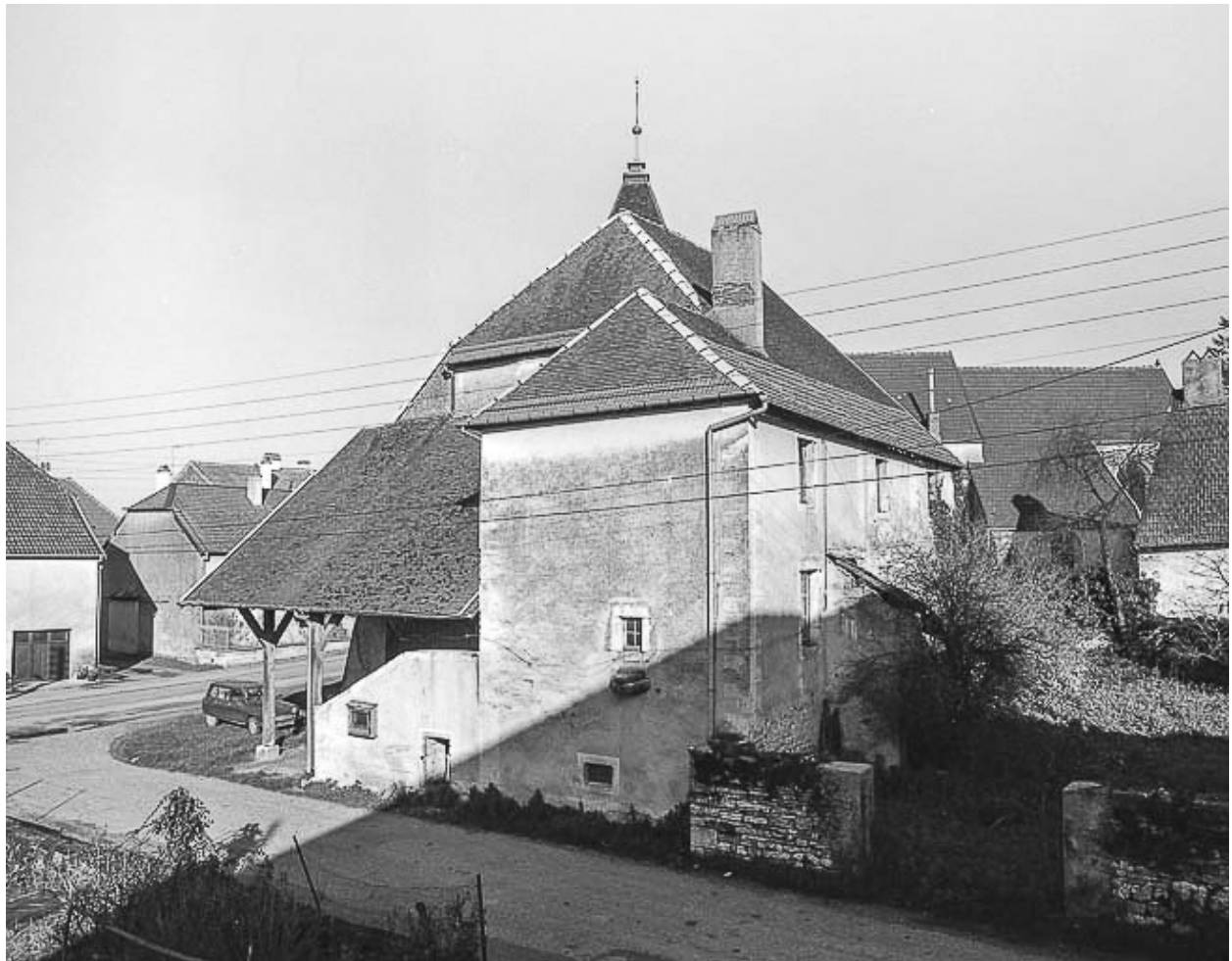
Façades postérieure et latérale droite en 1984.
