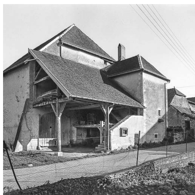
Détail : auvent et escalier extérieurs en 1984. Phot. Yves Sancey IVR43_19847000036X
