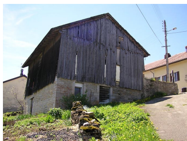
Pignon sud vu de trois quarts.
