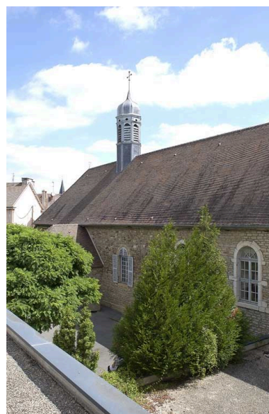
Façade postérieure. Phot. Michel Thierry IVR26_20032100408NUC2A
