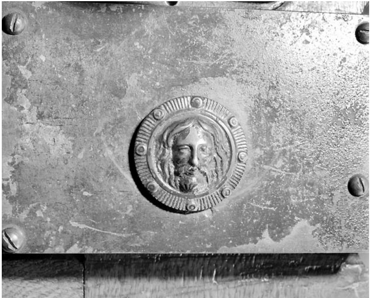
Porte principale : détail de la serrure.
