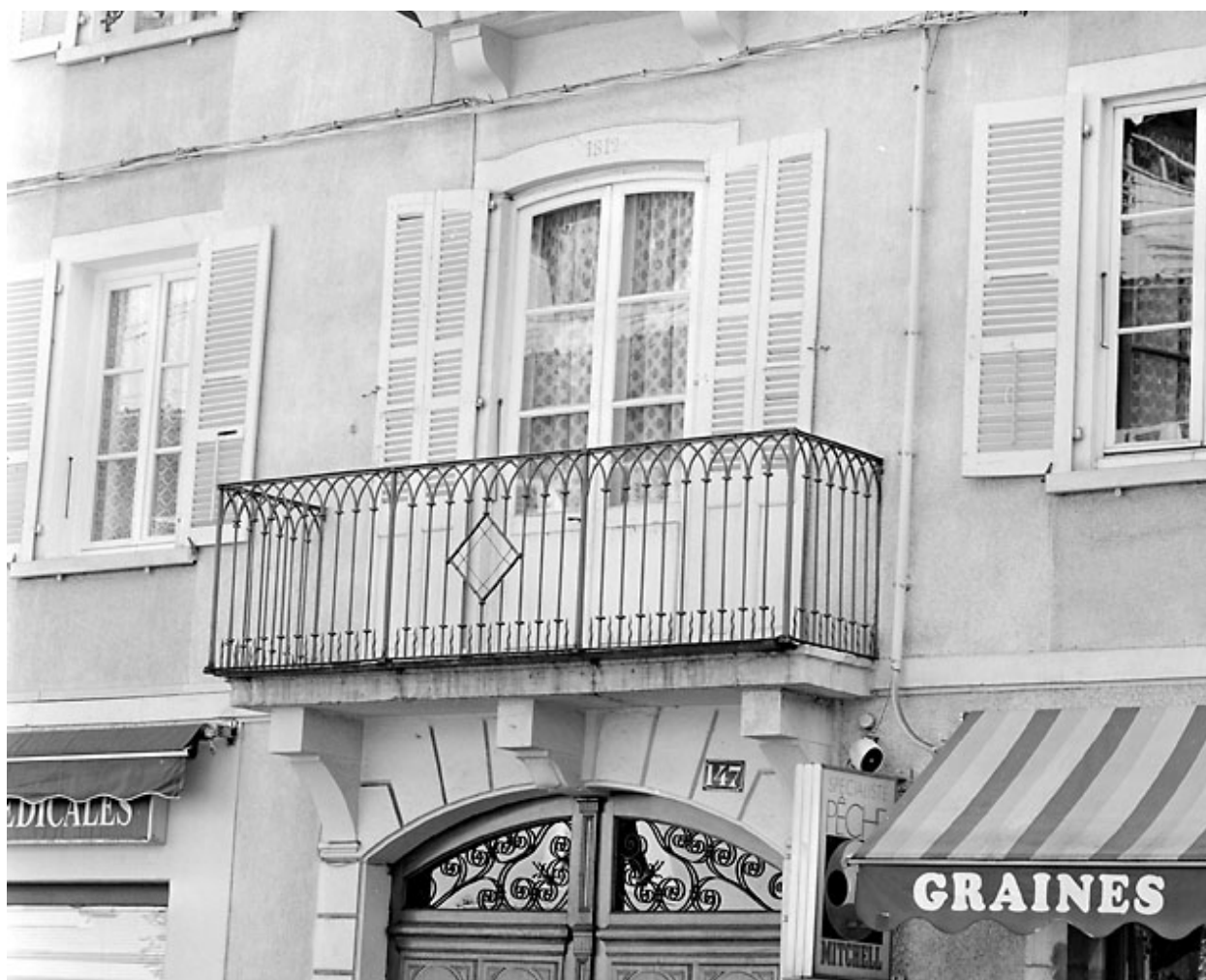
Porte-fenêtre et balcon du premier étage.
