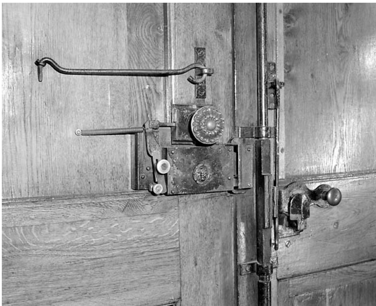
Porte principale : serrure et fermeture intérieure.
