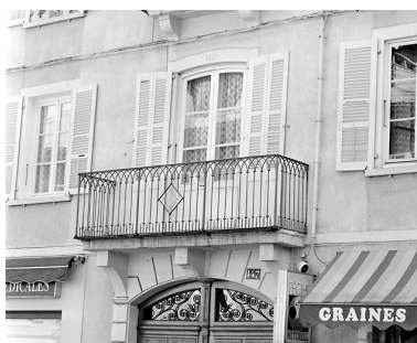
Porte-fenêtre et balcon du premier étage. Phot. Yves Sancey IVR43_20033900749X
