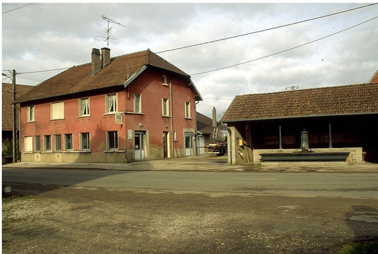
Vue d'ensemble depuis le sud.
