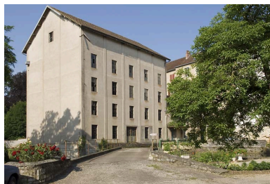
Façade antérieure de trois quarts. Phot. Jérôme Mongreville IVR43_20087000559NUC2A
