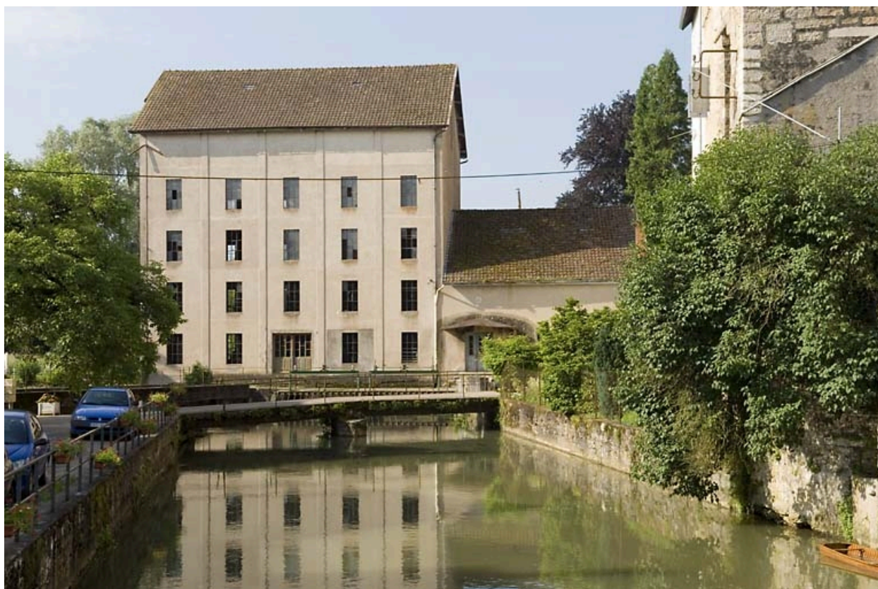
Vue depuis l'amont du bief.
