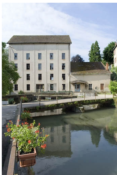
Vue d'ensemble depuis le nord. Phot. Jérôme Mongreville
