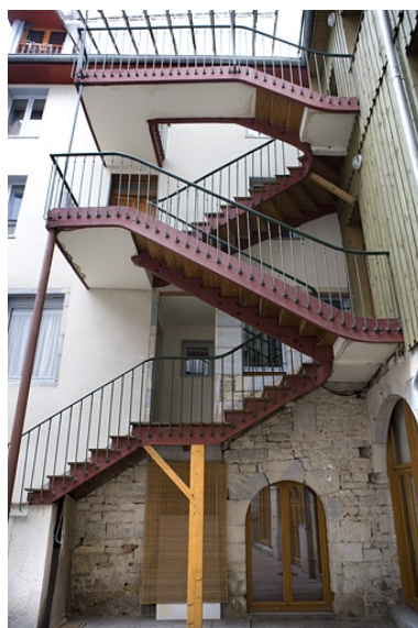
Deuxième cour : escalier extérieur récent. Phot. Yves Sancey IVR43_20102500269NUC2A
