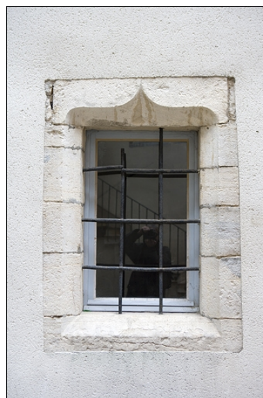
Premier logis secondaire, façade postérieure : détail d'une fenêtre en accolade.
