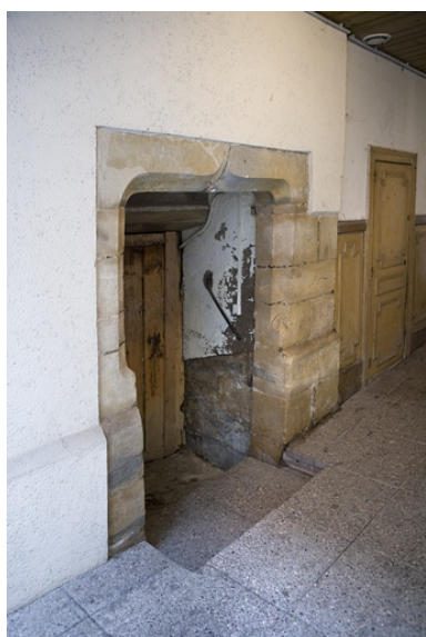
Premier logis secondaire : détail de la porte d'entrée de l'escalier en vis.
