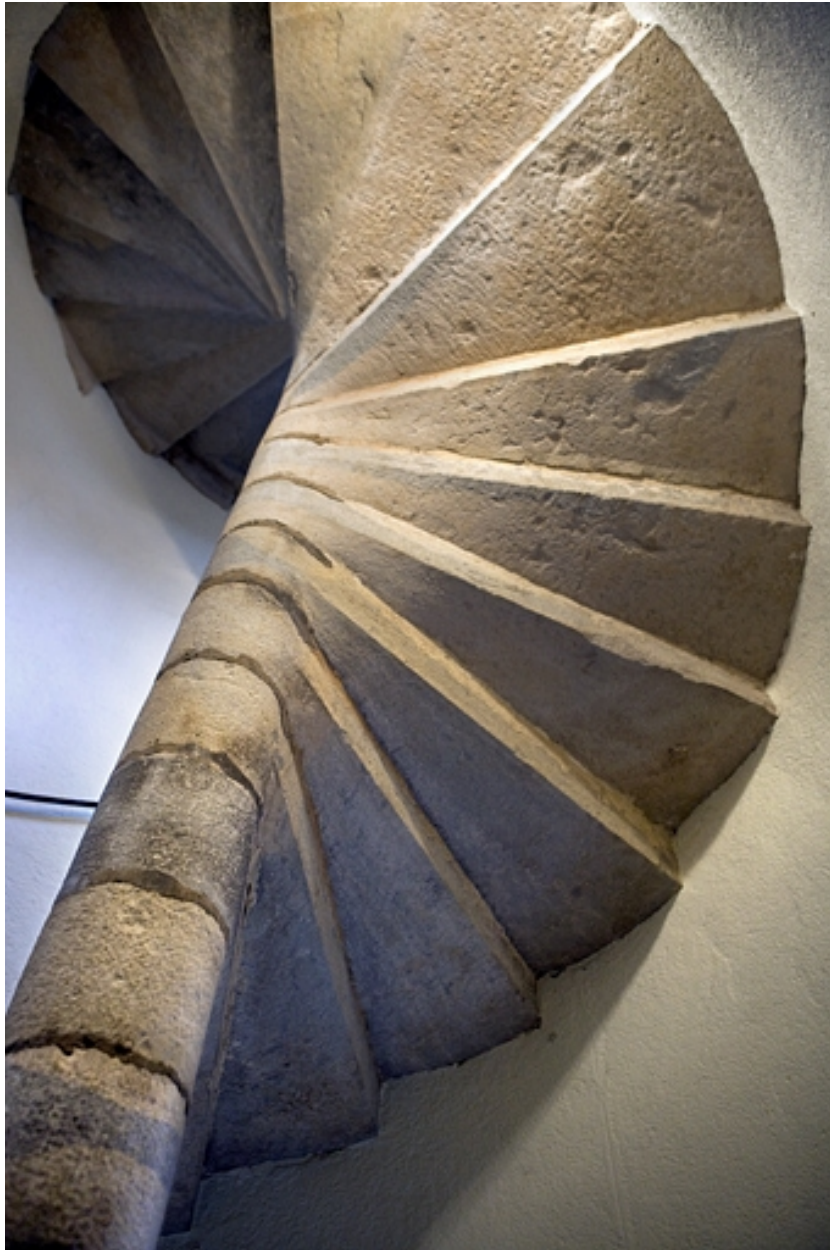
Détail de l'escalier en vis dans le premier logis secondaire : vue en contre-plongée.
