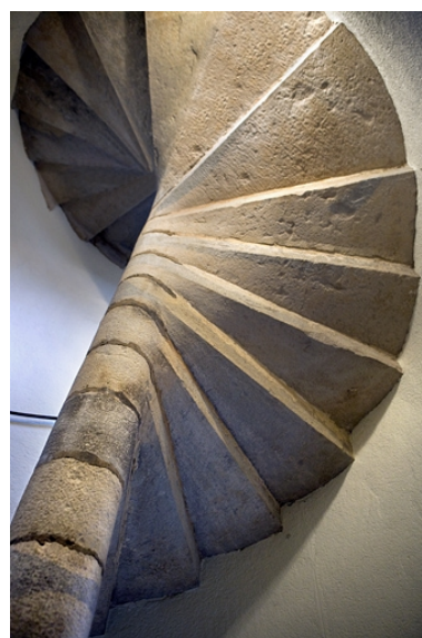
Détaill de l'escalier en vis dans le premier logis secondaire : vue en contre-plongée.
