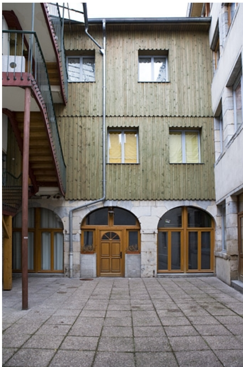
Deuxième cour : aile droite du logis secondaire avec d'anciennes dépendances artisanales au rez-de-chaussée.
