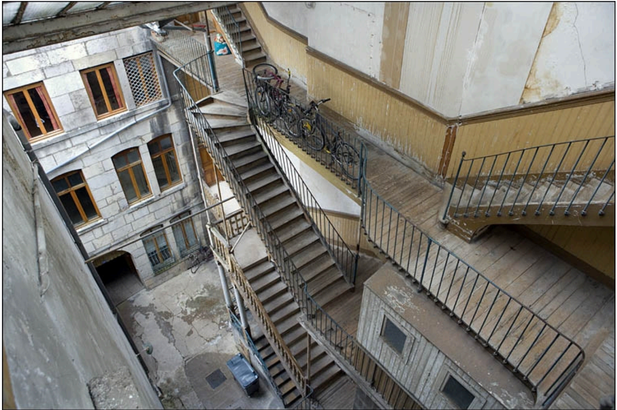
Vue d'ensemble de la façade antérieure du premier logis secondaire et de l'escalier à cage ouverte.
