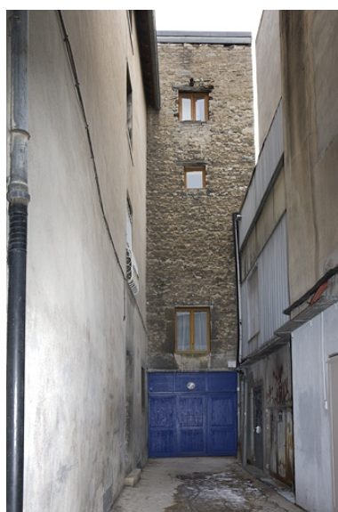
Deuxième cour : façade postérieure du logis secondaire donnant sur l'ancien trage. Phot. Yves Sancey IVR43_20102500274NUC2A
