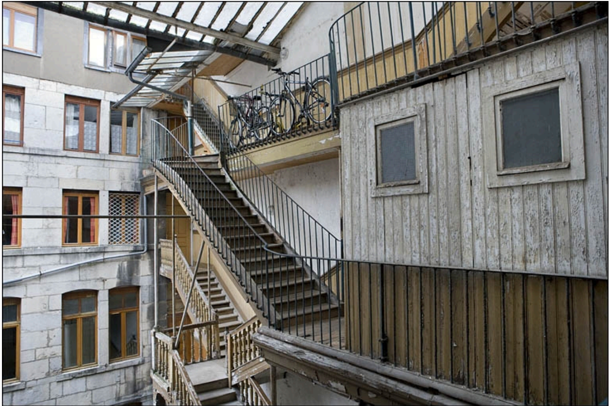
Détail des parties supérieures de la façade antérieure du premier logis secondaire et de l'escalier à cage ouverte.
