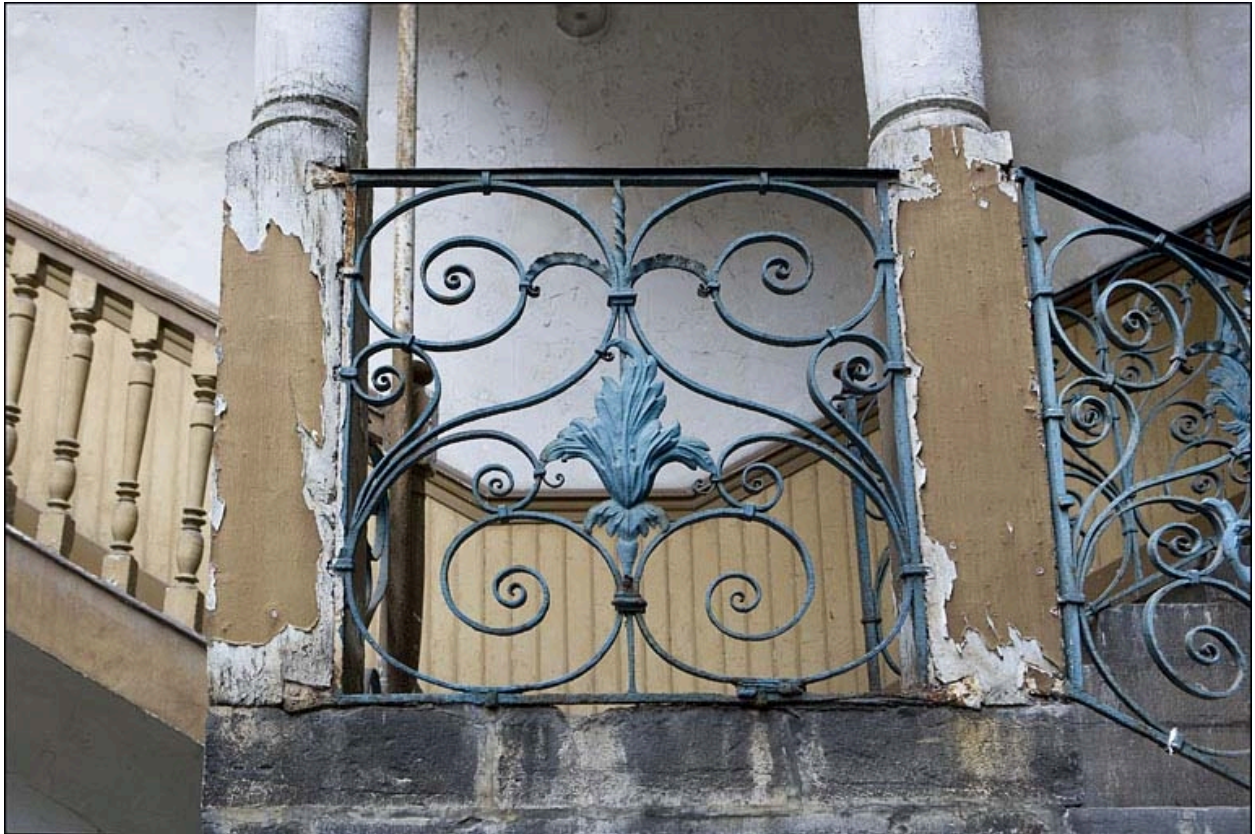
Détail d'une grille en ferronnerie du premier repos de l'escalier à cage ouverte.
