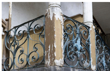
Détail de la rampe en ferronnerie de l'escalier à cage ouverte.
