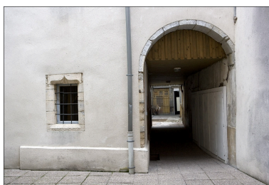
Premier logis secondaire, façade postérieure : détail du passage cocher.
