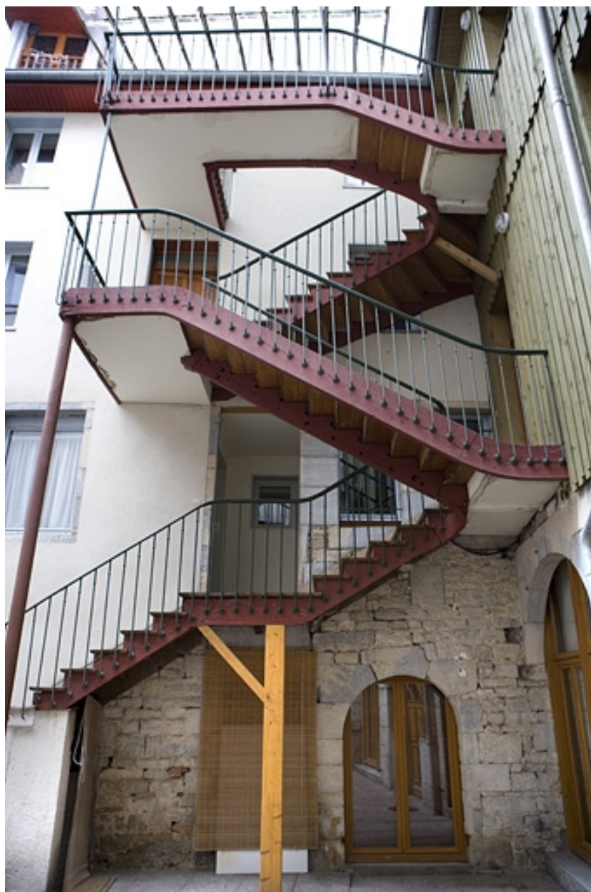
Deuxième cour : escalier extérieur récent.
