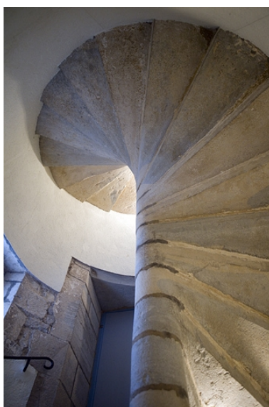
Premier logis secondaire : détail de l'escalier en vis avec la porte d'entrée.
