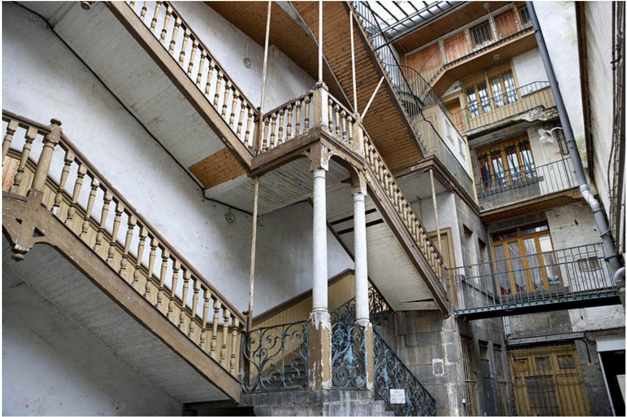
Vue partielle de la façade postérieure du logis principal et de l'escalier à cage ouverte.
