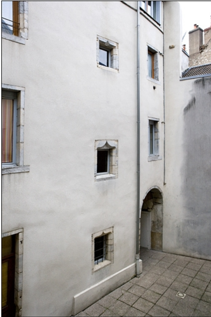
Façade postérieure du premier logis secondaire donnant sur la deuxième cour.
