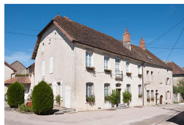
Vue générale sud-ouest Phot. Jérôme Mongreville IVR43_20137000204NUCA
