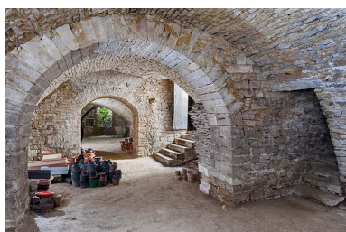
Vue générale de la cave Phot. Jérôme Mongreville IVR43_20137000625NUCA
