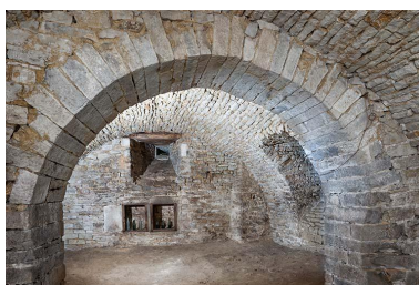
Vue générale de la cave Phot. Jérôme Mongreville IVR43_20137000626NUCA
