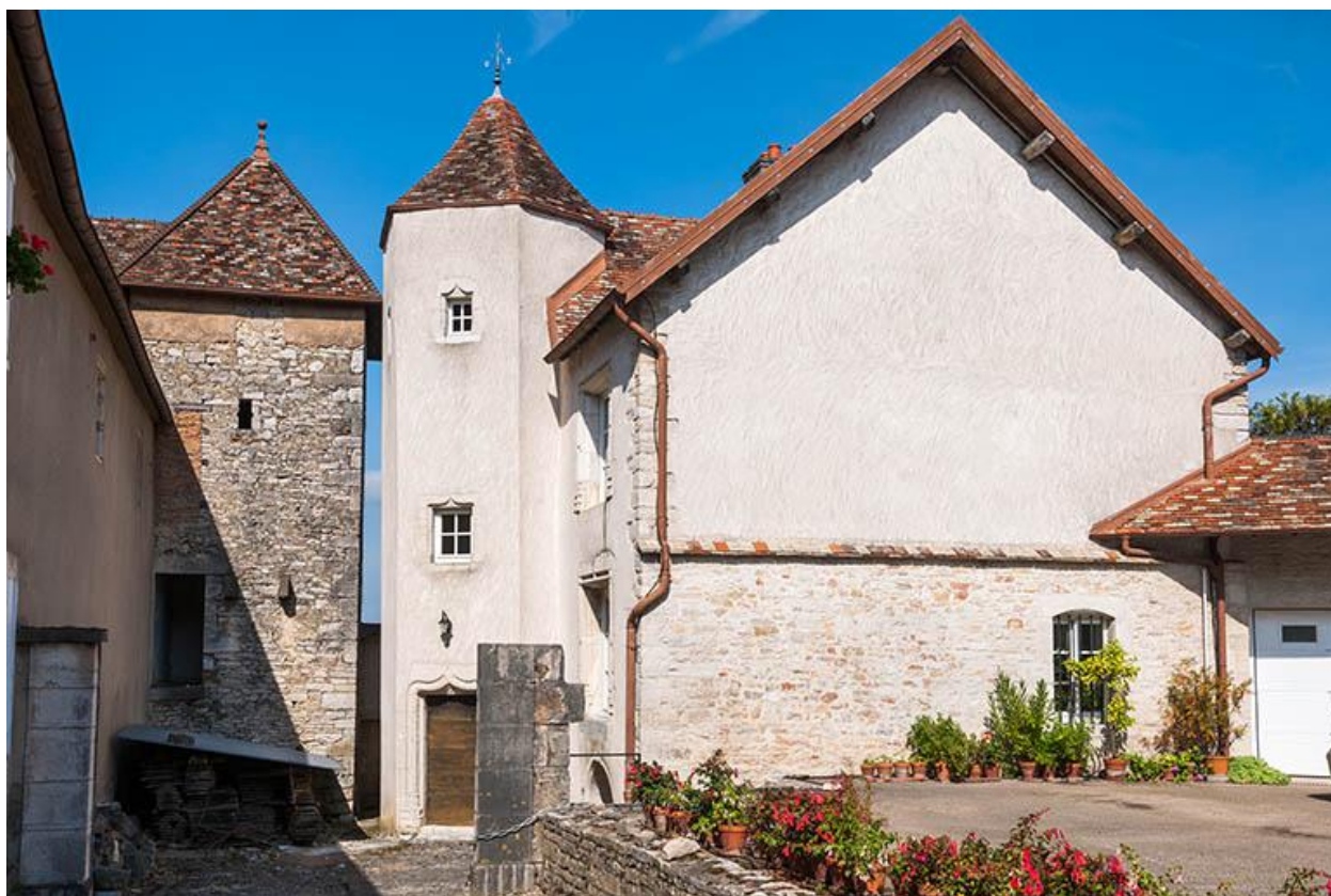
Ancienne maison située au nord-ouest
