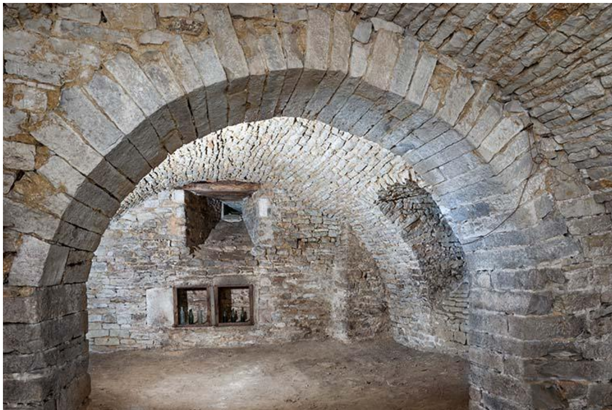
Vue générale de la cave
