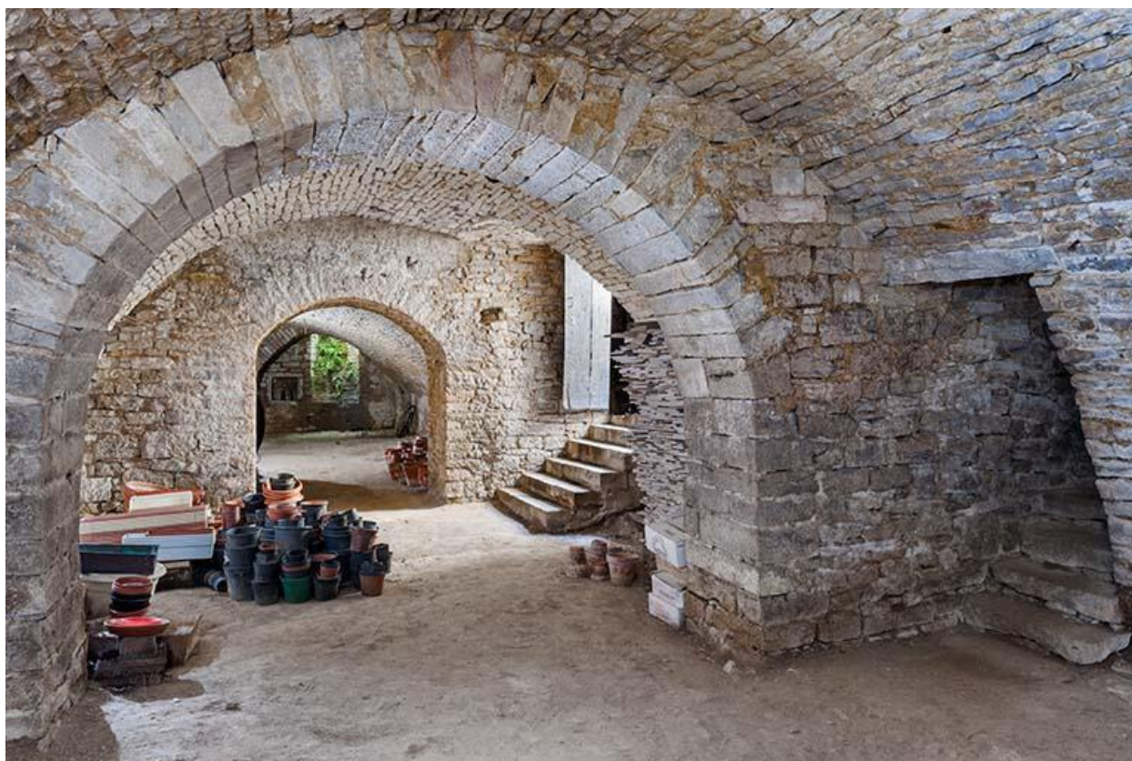
Vue générale de la cave
