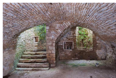
Vue générale de la cave Phot. Jérôme Mongreville IVR43_20137000627NUCA
