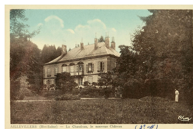
Aillevillers (Haute-Saône) - La Chaudeau, le nouveau Château. Phot. Jérôme Mongreville IVR43_20067000175NUCA
