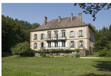
Façade sud vue de trois quarts droite. Phot. Jérôme Mongreville IVR43_20067000734NUCA
