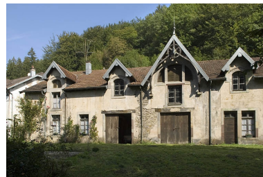
Logement, écuries et remises. Phot. Jérôme Mongreville IVR43_20067000732NUCA
