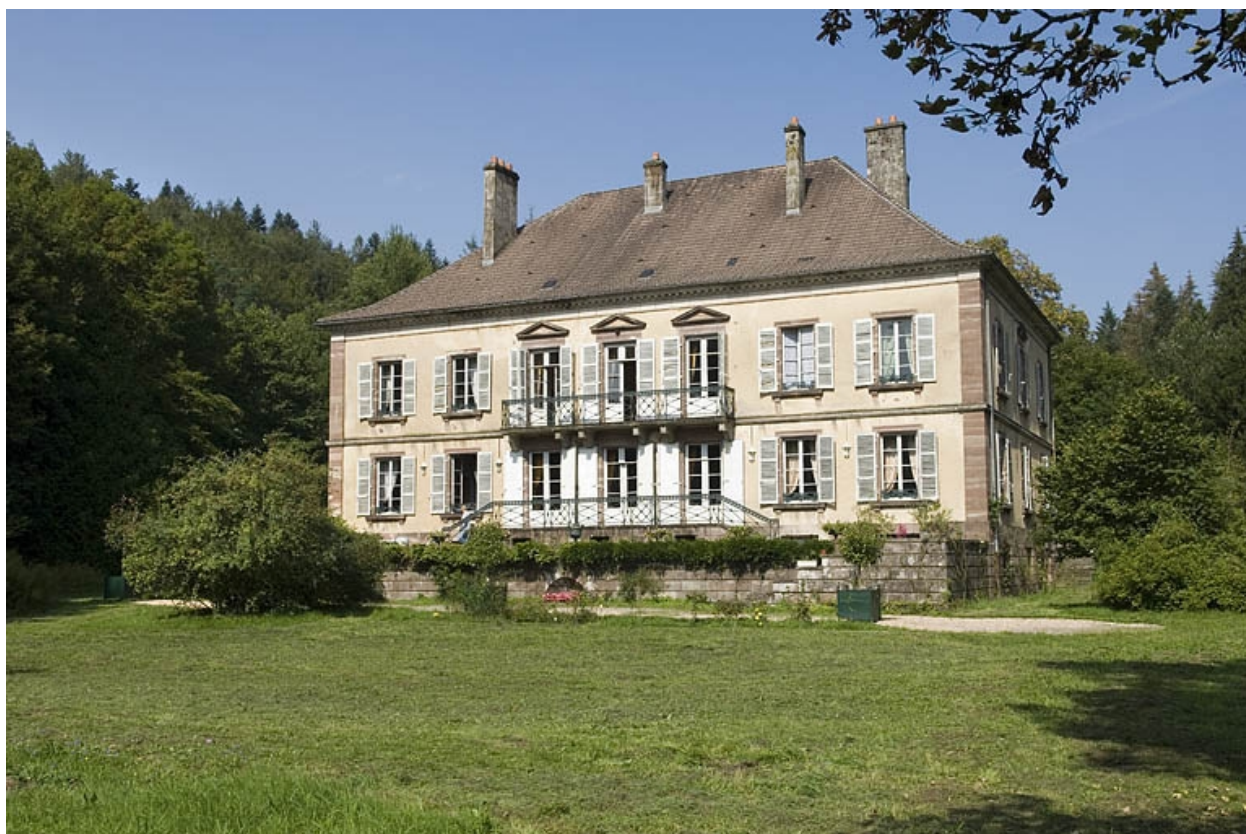
Façade sud vue de trois quarts droite.
