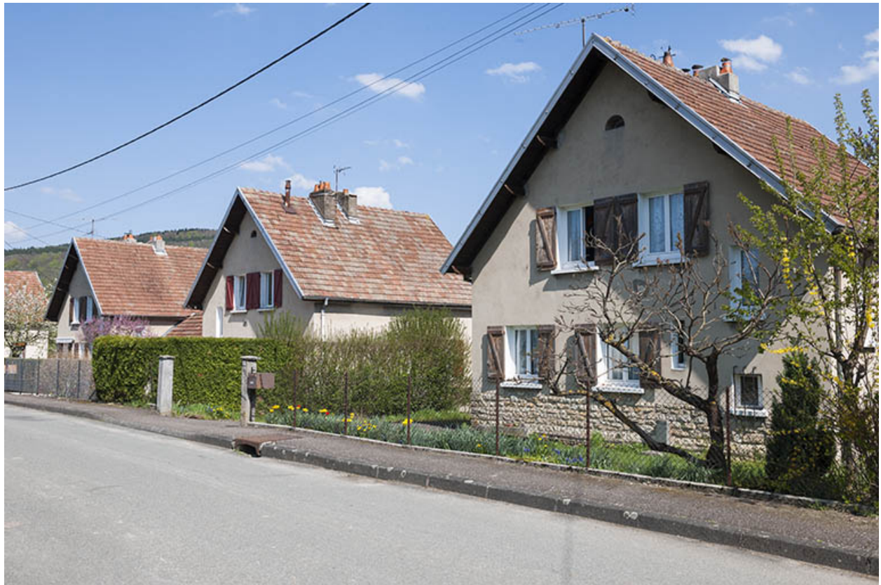
Alignement de façades rue de Champagne.
