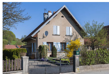
Façade antérieure d'une maison (rue des Ecoles). Phot. Jérôme Mongreville IVR43_20132500208NUC4A
