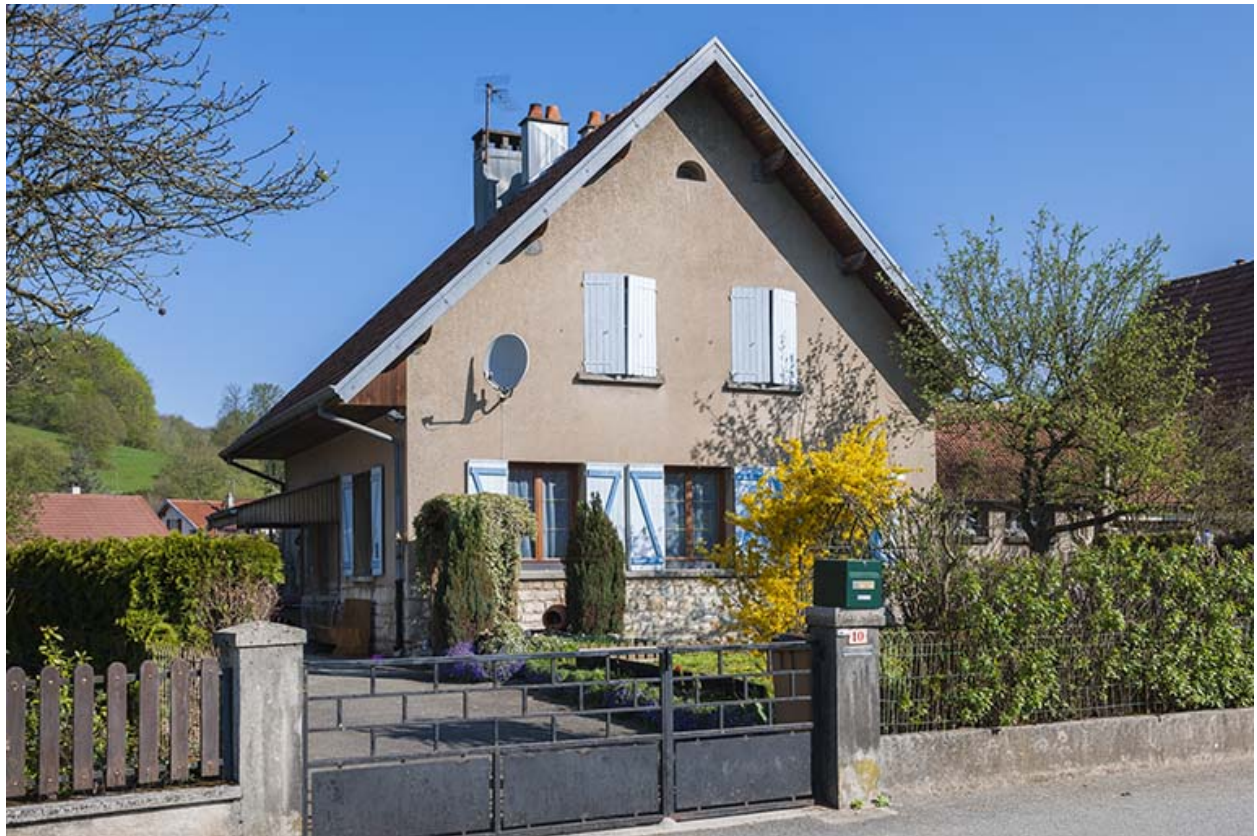
Façade antérieure d'une maison (rue des Ecoles).
