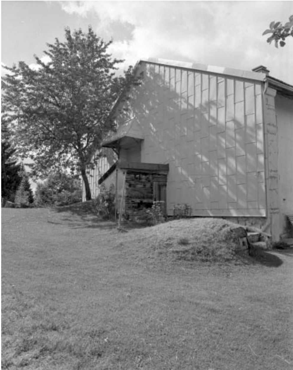
Face gauche recouverte d'un essentage de zinc.
