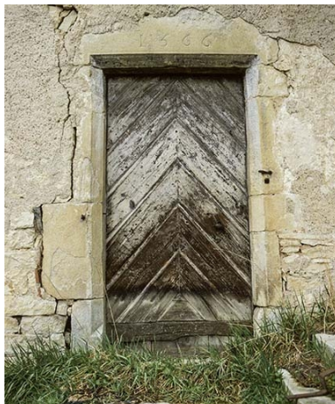
Porte d'entrée datée de 1566. Phot. Yves Sancey IVR43_19827000484XA
