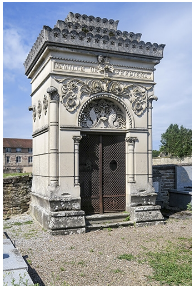
Vue d'ensemble. Phot. Fabien Dufoulon IVR43_20217000434NUC2A
