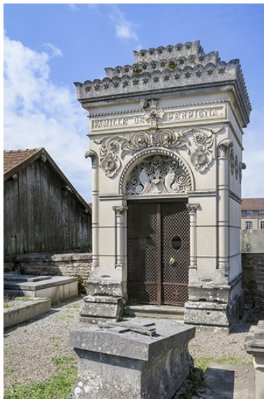
Vue d'ensemble. Phot. Fabien Dufoulon IVR43_20217000433NUC2A
