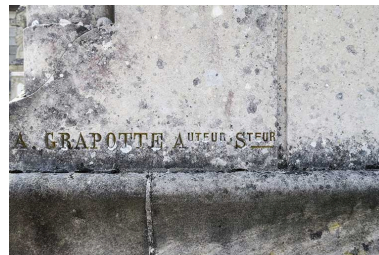
Détail, signature : A. GRAPOTTE. Phot. Fabien Dufoulon IVR43_20217000435NUC2A
