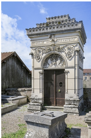
Vue d'ensemble. Phot. Fabien Dufoulon IVR43_20217000433NUC2A
