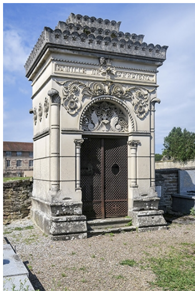
Vue d'ensemble. Phot. Fabien Dufoulon IVR43_20217000434NUC2A
