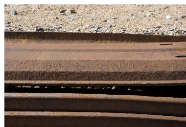
Inscription sur une traverse double (gare de Champagnole) : H. Wendel. Phot. Yves Sancey IVR43_20083900886NUC2A
