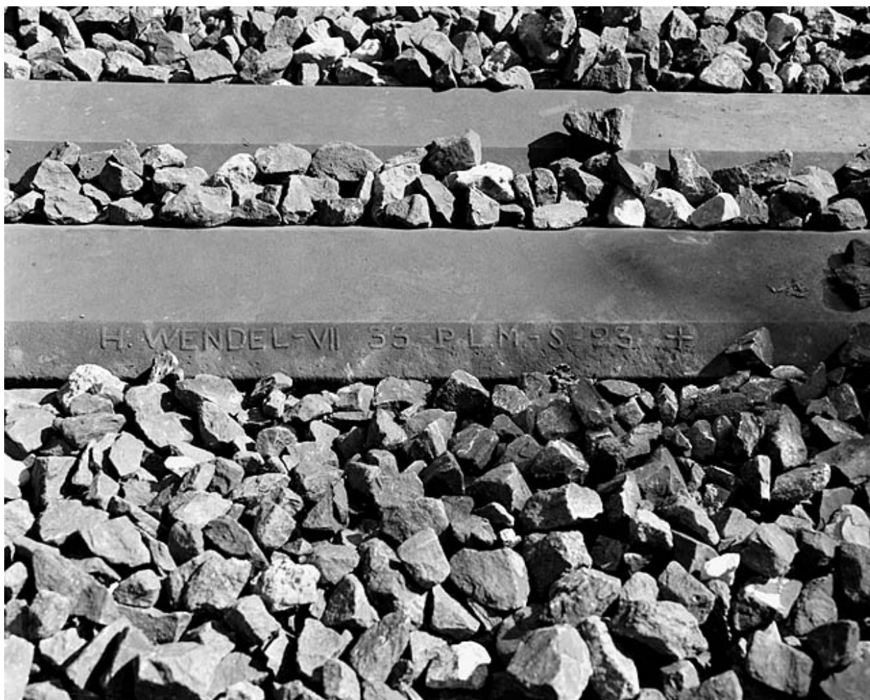
Inscription sur une traverse double : H. Wendel. Cette traverse est en place près du point kilométrique 100.200, peu avant le souterrain d'Arbent 1 (commune d'Arbent, Ain).
