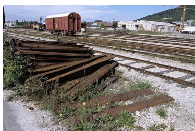
Traverses métalliques réformées stockées en gare de Champagnole. Phot. Yves Sancey IVR43_20043900172ZA
