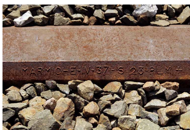
Inscription sur une traverse simple : Marmiche. Cette traverse est en place près du point kilométrique 042.500, entre le tunnel de la Savine et le passage à niveau n ° 33 (commune de Morbier, Jura). Phot. Yves Sancey IVR43_20053900301ZA
