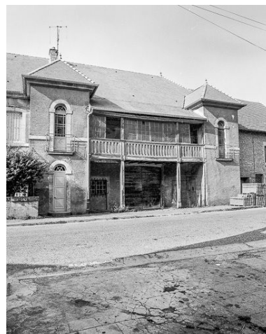
Détail de la façade latérale droite. Phot. Dominique Dominguez IVR43_19807000338X
