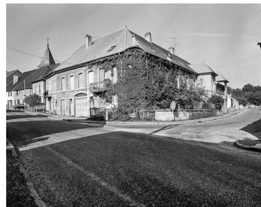
Vue d'ensemble des deux façades sur rue. Phot. Dominique Dominguez IVR43_19807000335X
