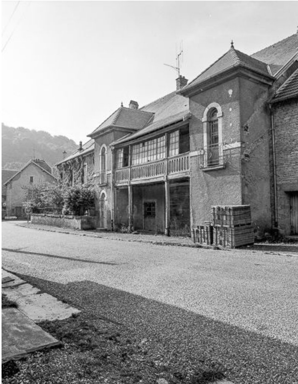
Façade latérale droite.
