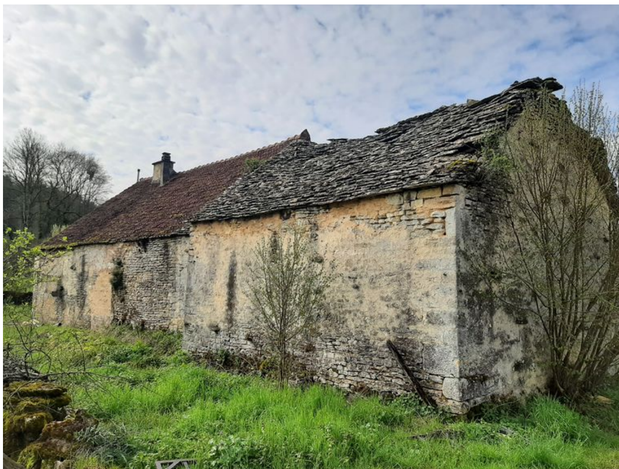
Vue de l'élévation nord de la grange.
