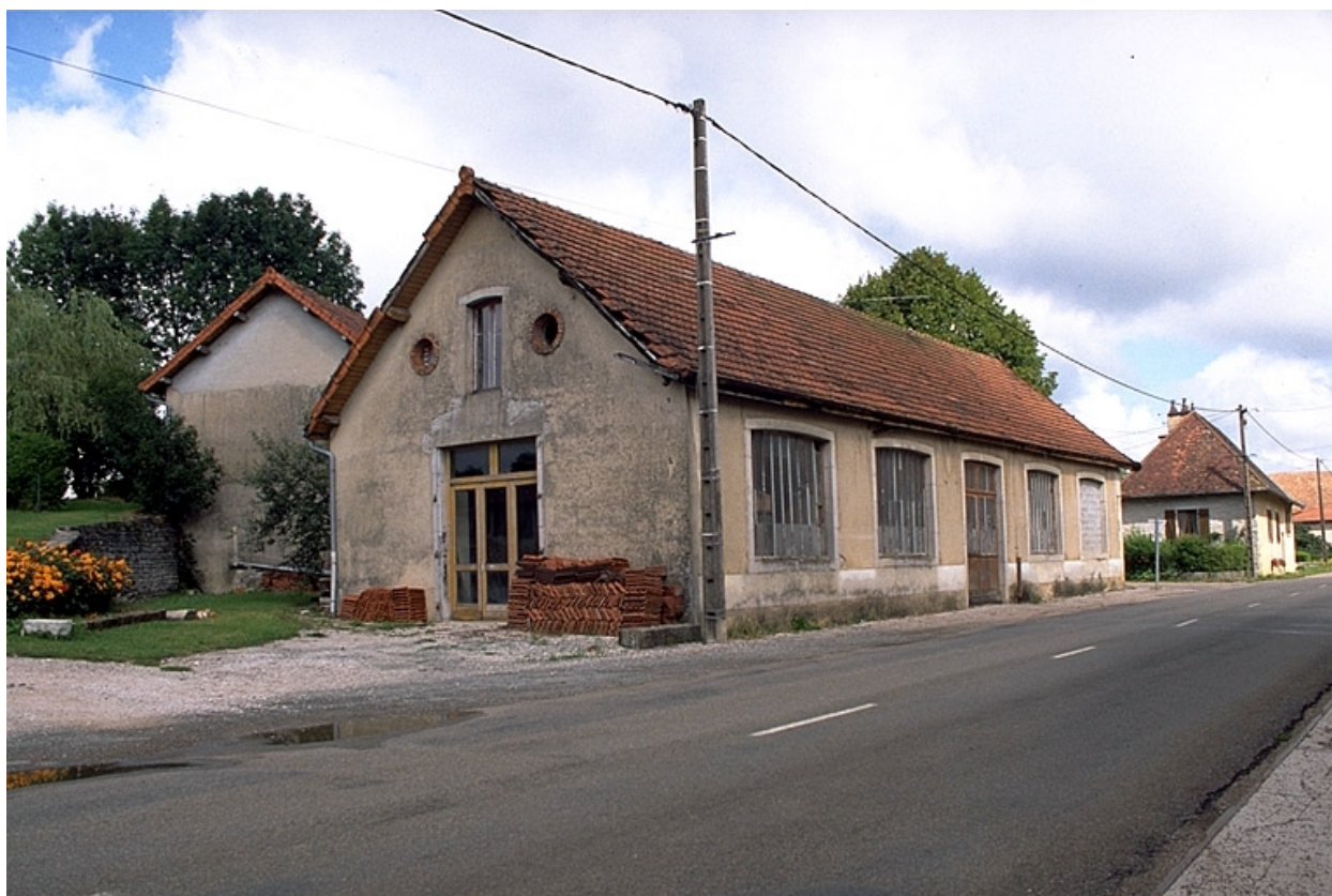
Atelier de fabrication depuis la route.
