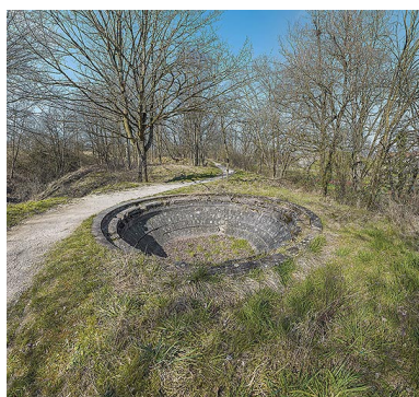
Redoute de Saint-Apollinaire : cuve d'une batterie anti-aérienne. Phot. Thierry Kuntz IVR26_20252100122NUC4A
