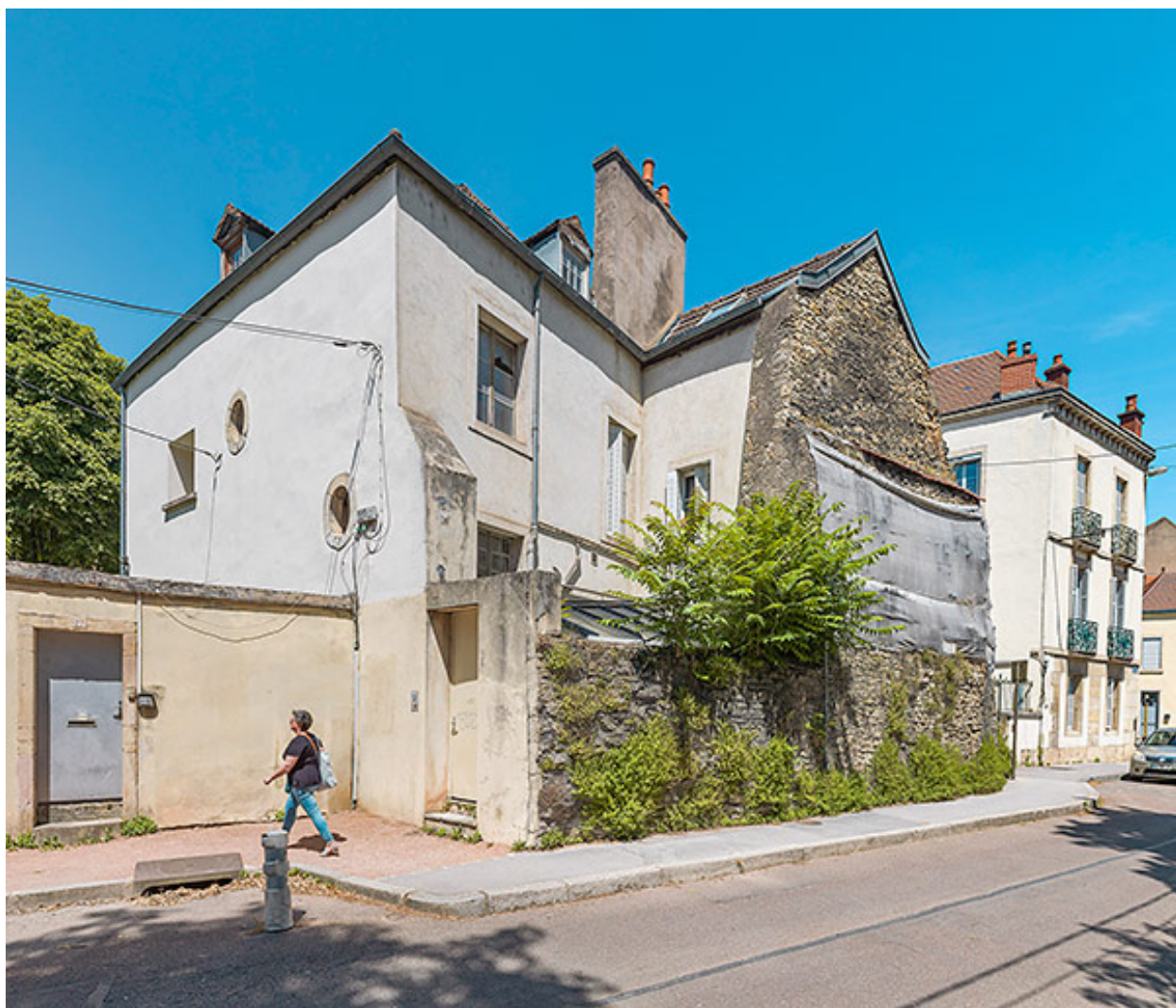
Tronçon du rempart, rue Berlier.
