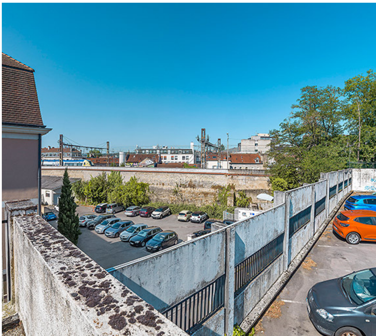
Le rempart de la Miséricorde, vue depuis le parking aérien.
