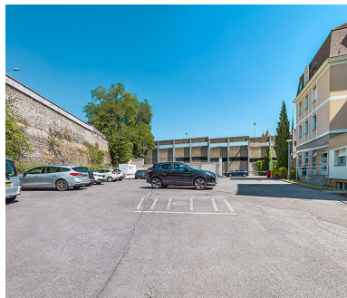
Le rempart de la Miséricorde (à gauche). Phot. Thierry Kuntz IVR26_20252100357NUC4A
