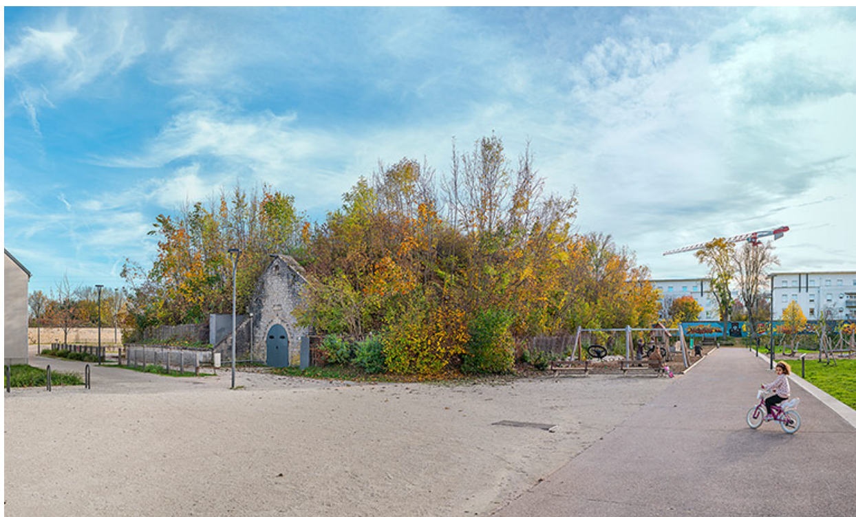
Site de l'ancien arsenal de Dijon : magasin à poudre V1.
