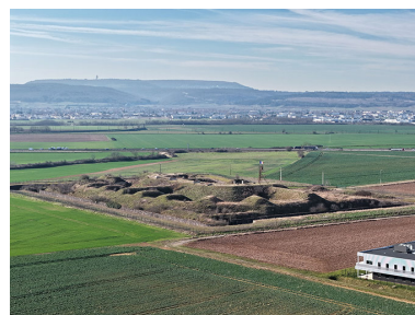
Le Mont Afrique et le fort de Beauregard (au premier plan). (vue aérienne). Phot. Nicolas Douriaux IVR26_20262100379NUC4A
