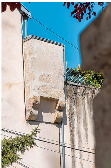
Vestige d'un ouvrage fortifié médiéval, rue Berlier. Phot. Thierry Kuntz IVR26_20252100370NUC4A
