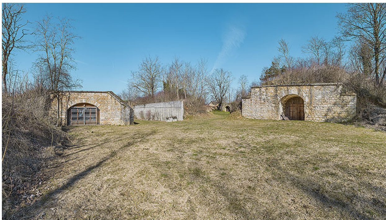
Batterie annexe du fort d'Asnières, située sur la commune de Norgès.
