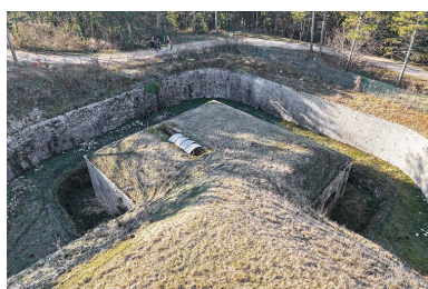
Fort de la Motte-Giron : double caponnière. (vue aérienne). Phot. Nicolas Douriaux IVR26_20262100394NUC4A
