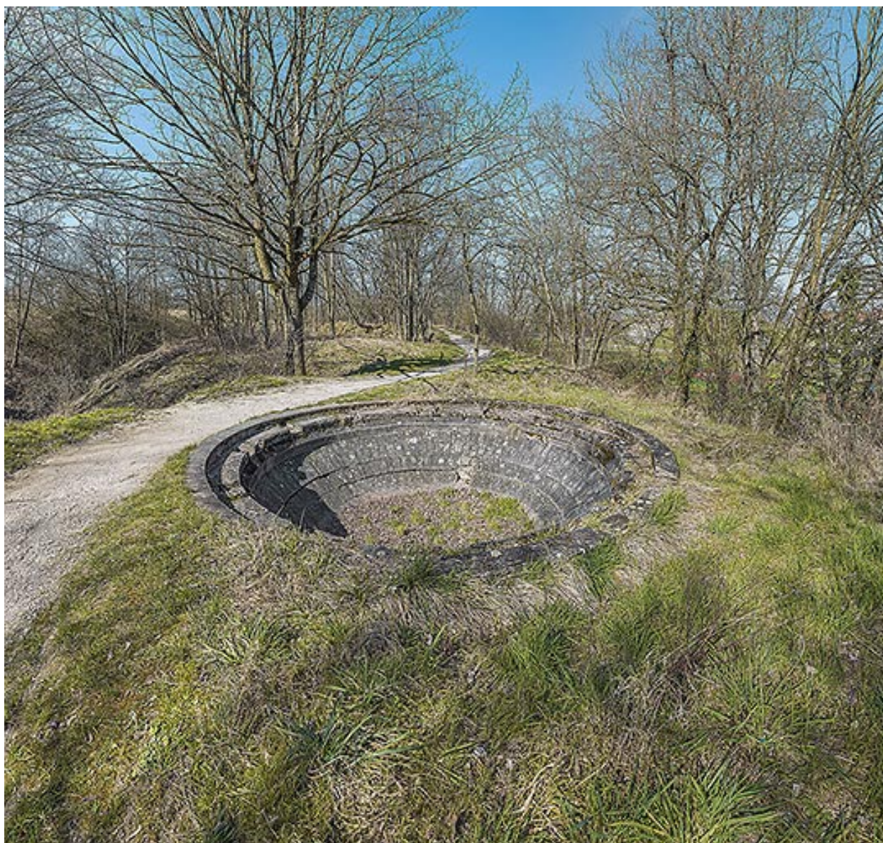
Redoute de Saint-Apollinaire : cuve d'une batterie anti-aérienne.
