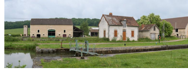
Vue d'amont du site d'écluse. Phot. Pierre-Marie Barbe-Richaud IVR26_20135800413NUC4AQ
