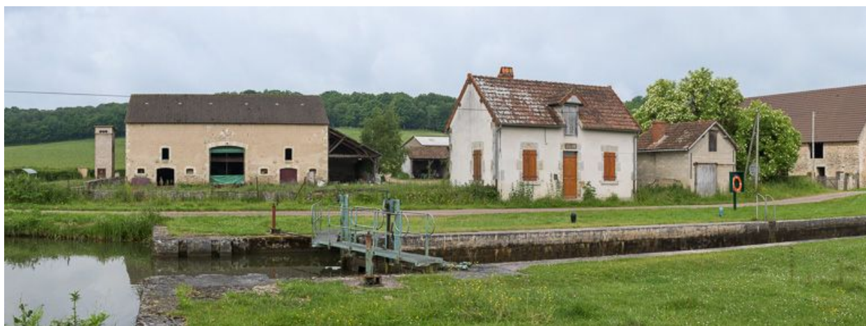
Vue d'amont du site d'écluse.
