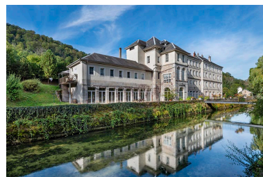
Façade principale, vue de trois quarts. Phot. Jérôme Mongreville IVR43_20222500252NUC4A
