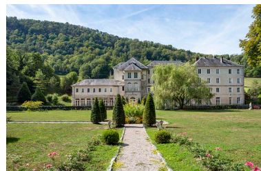
Façade principale, vue de face. Phot. Jérôme Mongreville IVR43_20222500272NUC4A
