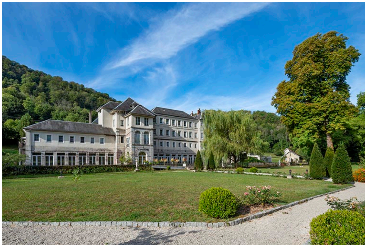
Façade principale, vue de trois quarts.
