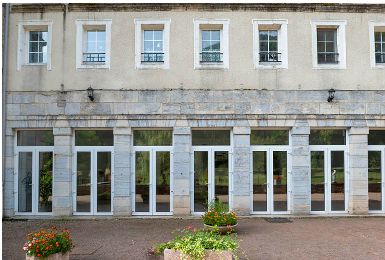
Façade principale, vue de face, détail : rez-de-chaussée et étage.
