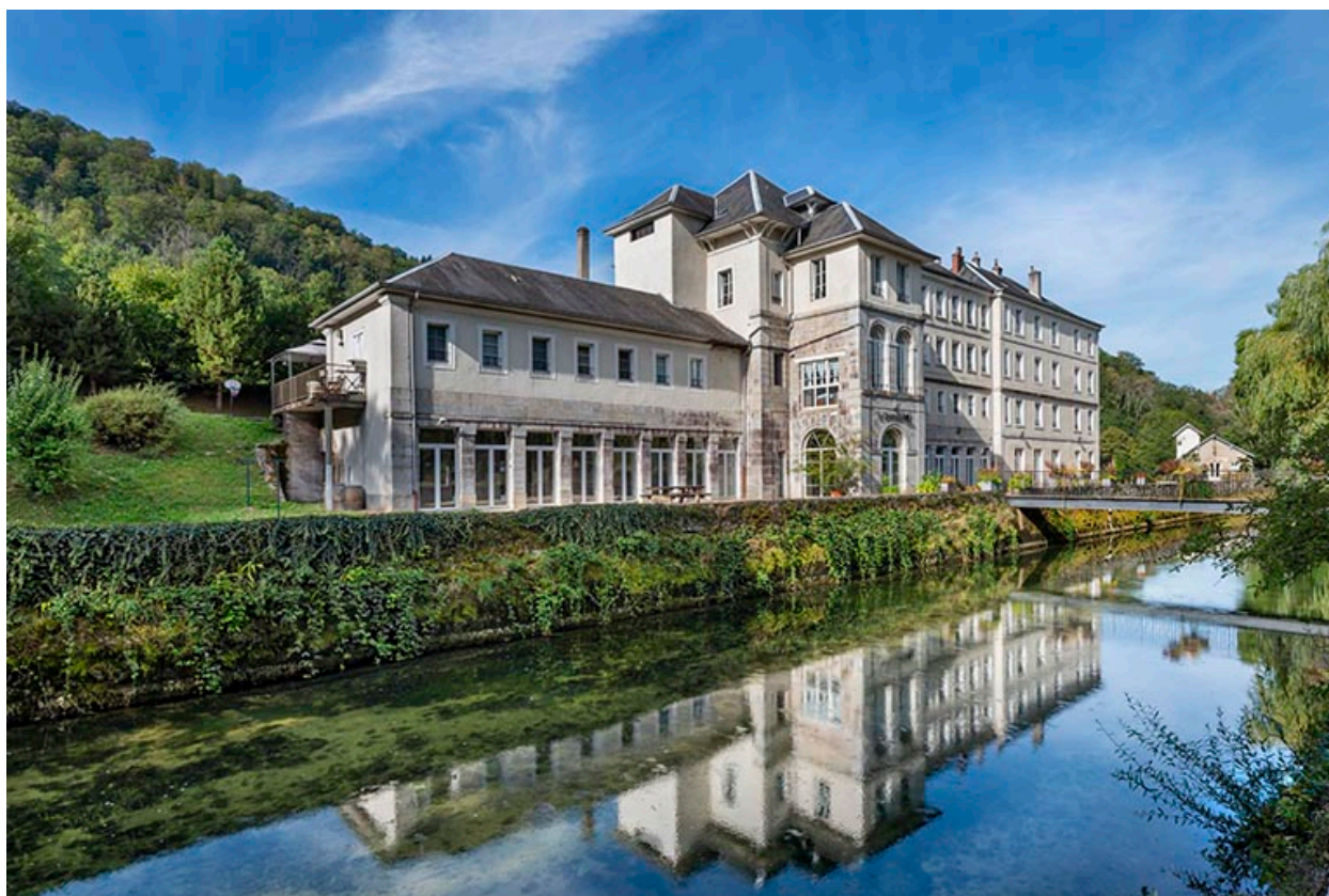
Façade principale, vue de trois quarts.
