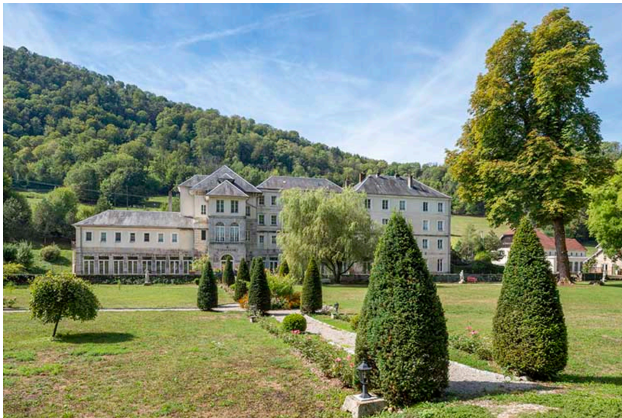
Façade principale, vue de trois quarts.
