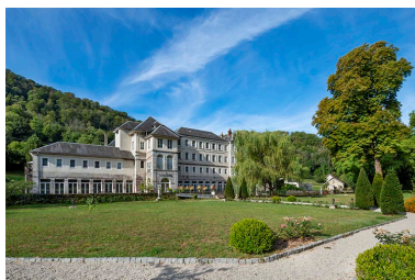
Façade principale, vue de trois quarts. Phot. Jérôme Mongreville IVR43_20222500251NUC4A
