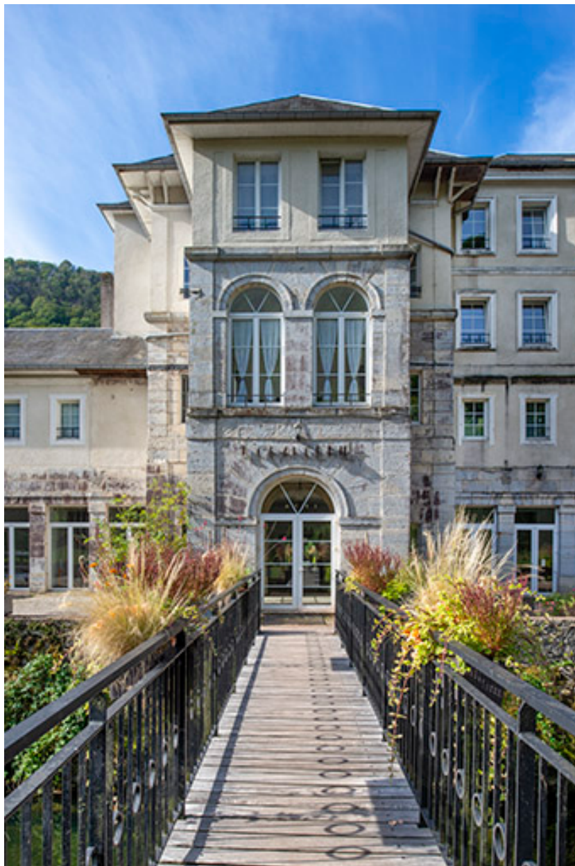
Façade principale, vue de face, détail : avant-corps central.
