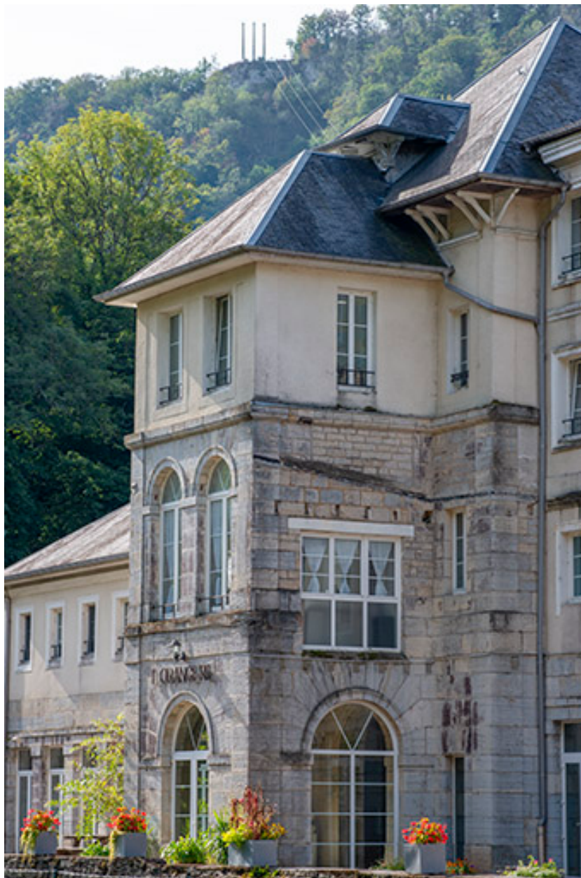
Façade principale, vue de trois quarts, détail : avant-corps central.
