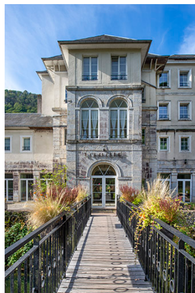
Façade principale, vue de face, détail : avant-corps central. Phot. Jérôme Mongreville IVR43_20222500255NUC4A
