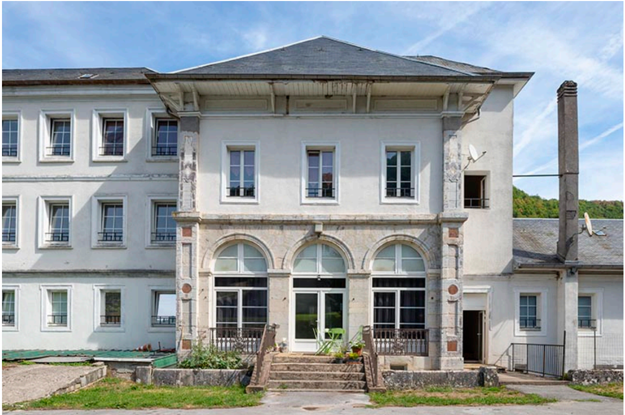
Façade arrière, vue de face, détail : avant-corps central.
