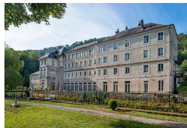
Façade principale, vue de trois quarts. Phot. Jérôme Mongreville IVR43_20222500256NUC4A
