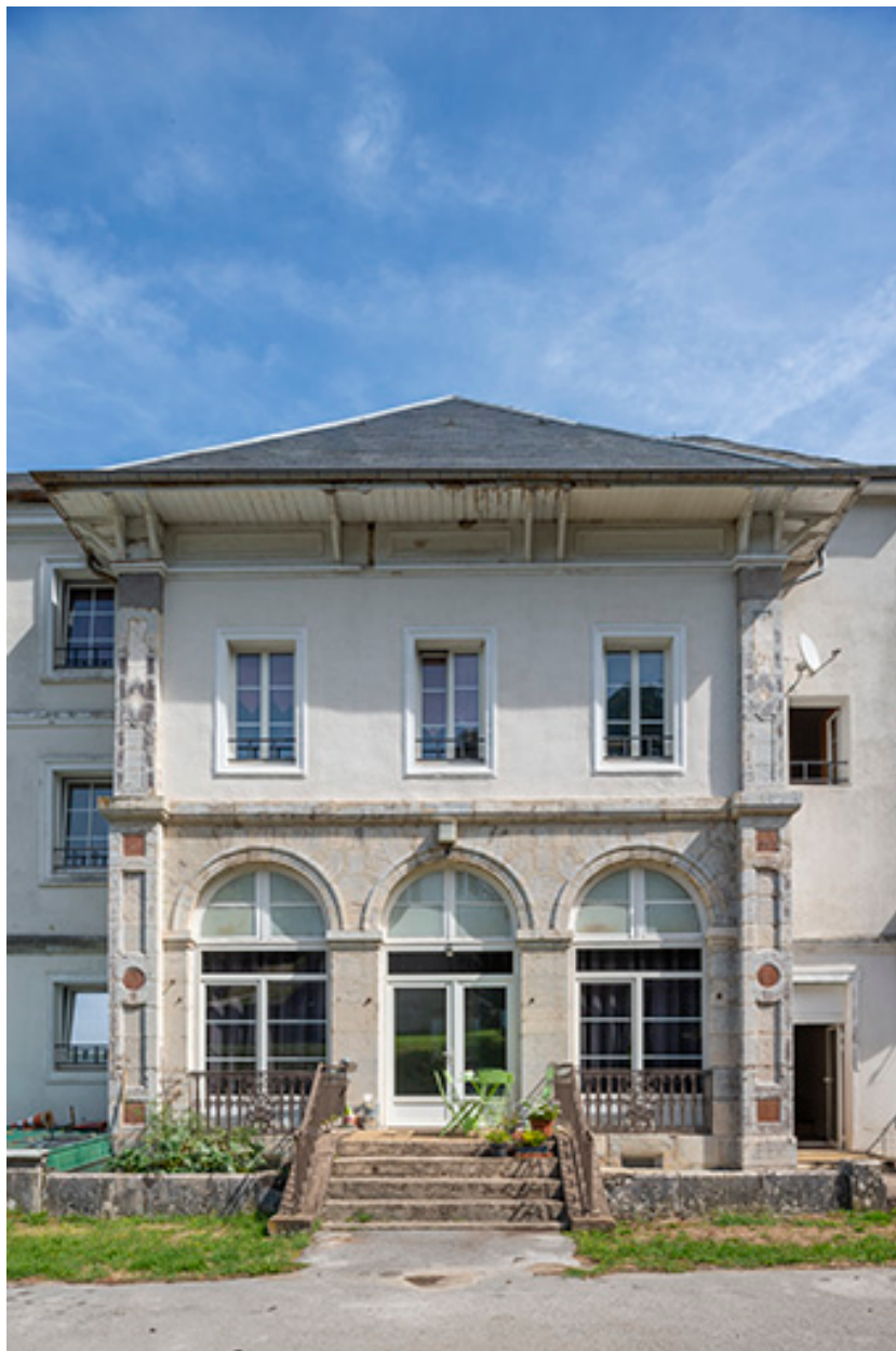
Façade arrière, vue de face, détail : avant-corps central.
