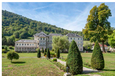
Façade principale, vue de trois quarts. Phot. Jérôme Mongreville IVR43_20222500273NUC4A
