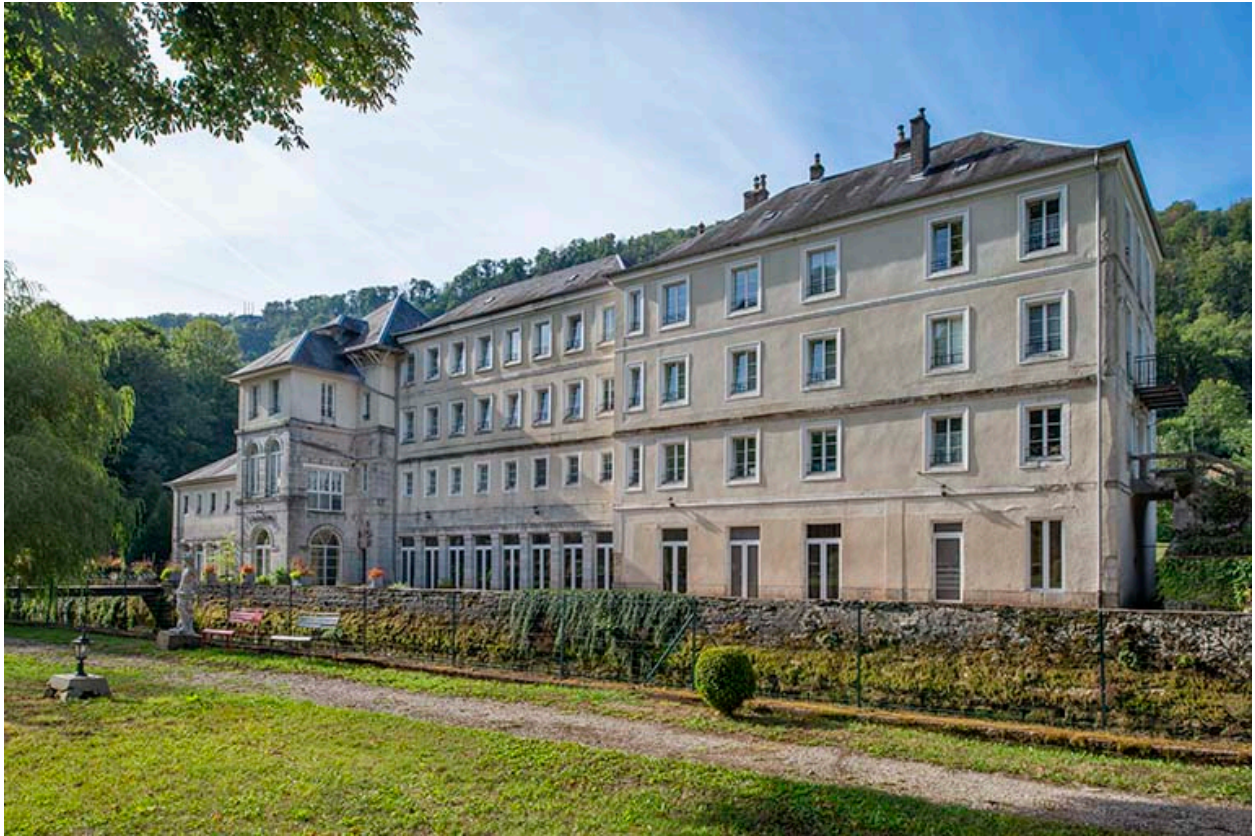
Façade principale, vue de trois quarts.
