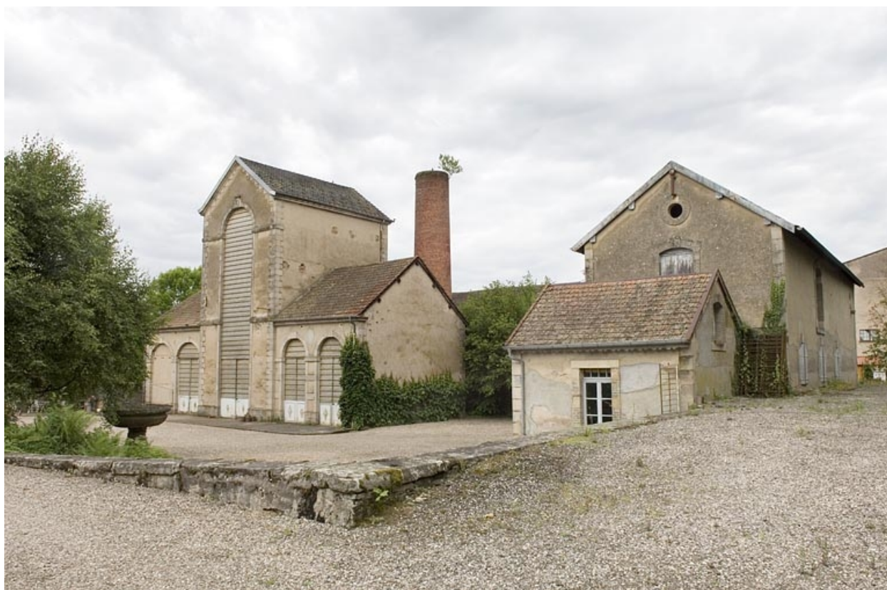
Bâtiment de rectification, bureau et entrepôt industriel.
