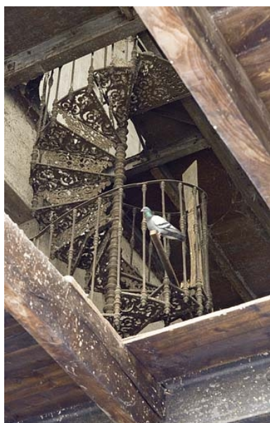
Bâtiment de rectification. Escalier intérieur en fonte. Phot. Jérôme Mongreville IVR43_20097000342NUC2A
