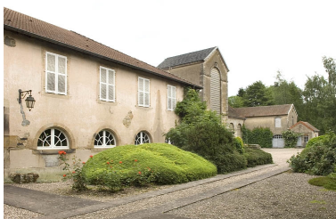
Aile nord (anciennes écuries). Phot. Jérôme Mongreville IVR43_20097000338NUC2A
