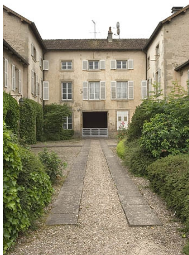
Façade antérieure du relais de poste. Phot. Jérôme Mongreville IVR43_20097000336NUC2A
