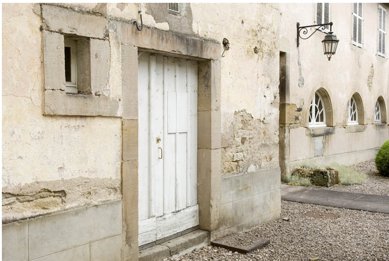
Détail de la façade de l'aile nord.
