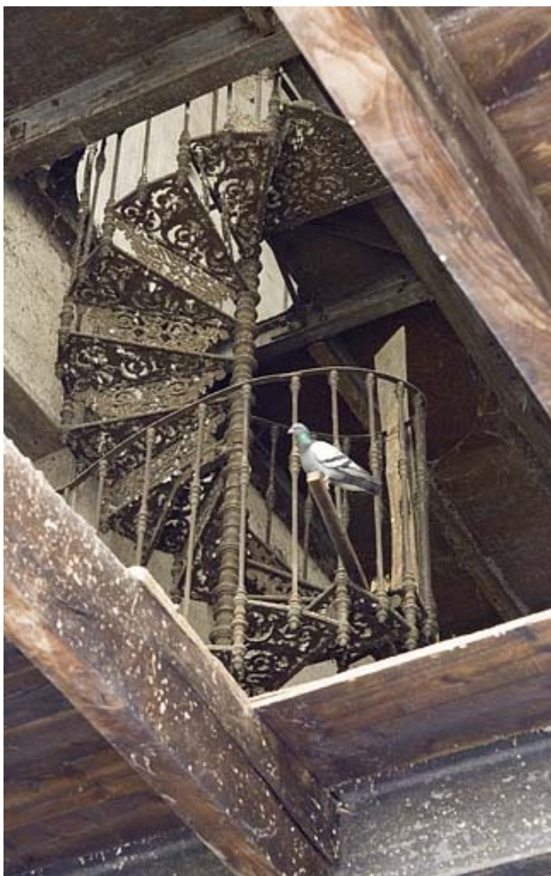
Bâtiment de rectification. Escalier intérieur en fonte.
