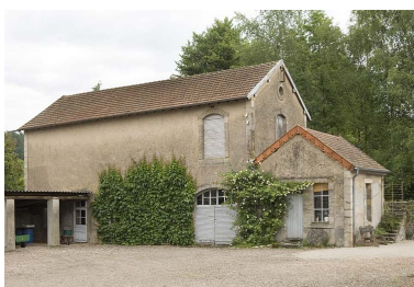
Entrepôt industriel et bureau. Phot. Jérôme Mongreville IVR43_20097000334NUC2A
