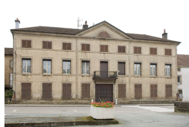
Vue de face du relais de poste. Phot. Jérôme Mongreville IVR43_20097000344NUC2A
