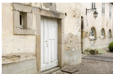
Détail de la façade de l'aile nord. Phot. Jérôme Mongreville IVR43_20097000339NUC2A
