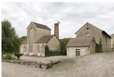
Bâtiment de rectification, bureau et entrepôt industriel. Phot. Jérôme Mongreville IVR43_20097000332NUC2A
