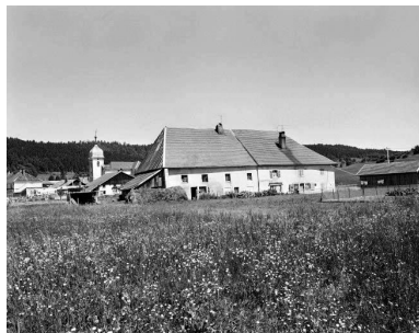
Vue d'ensemble dans le village. Phot. Yves Sancey IVR43_19812500182X
