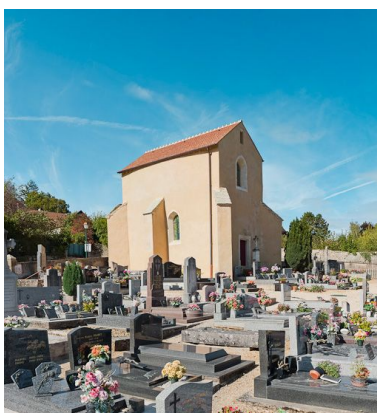
Vue de trois-quarts, depuis le cimetière. Phot. Pierre-Marie Barbe-Richaud IVR26_20122101469NUC4AQ
